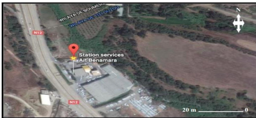
Fig. 2 : Image satellitaire de la station-service de Boukhalfa (Google earth)
