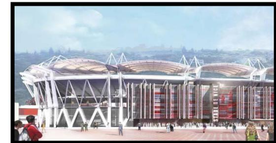
Figure 104 : stade de Nice utilisation d'une exo, toiture
