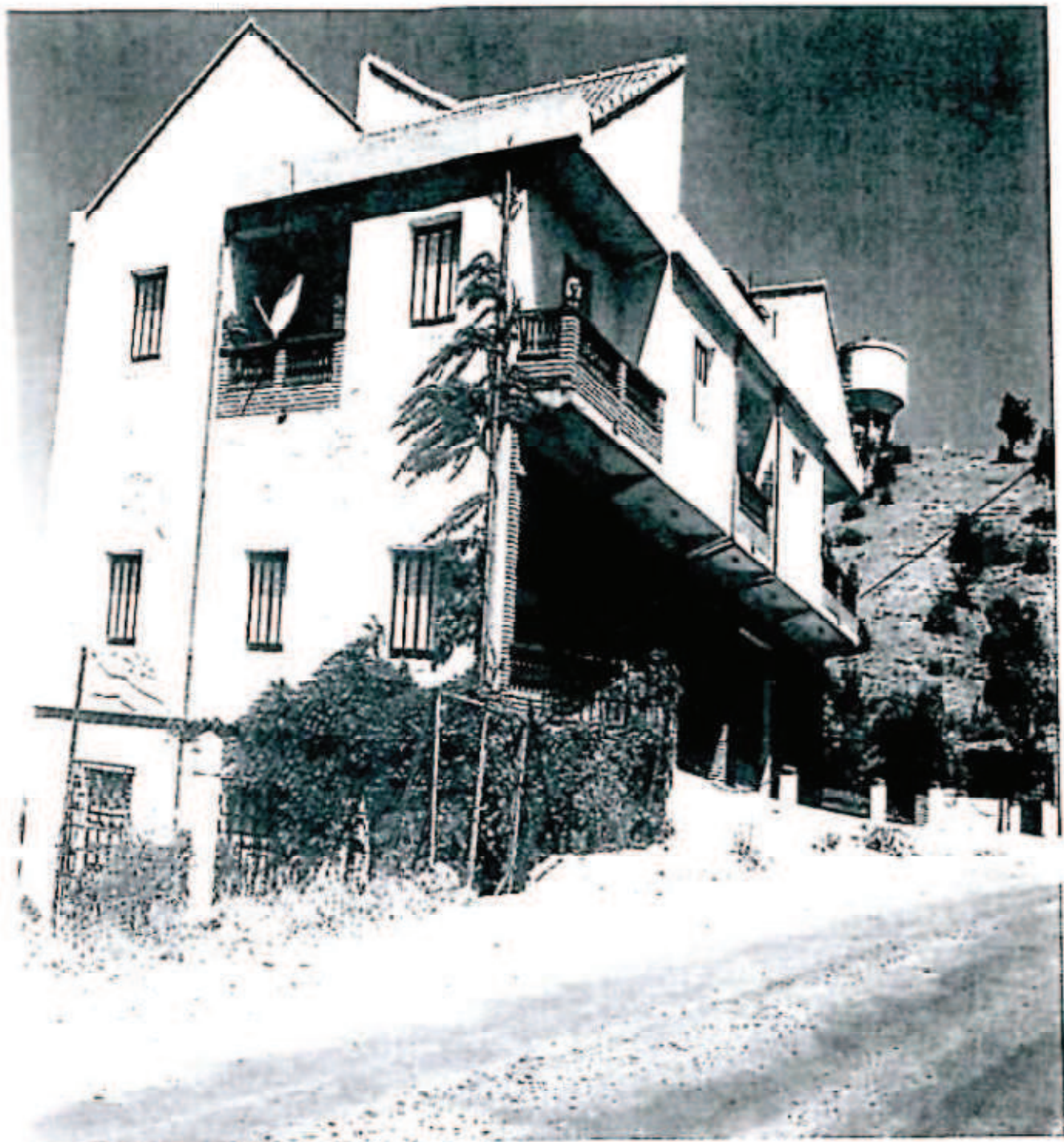
Nouvelle construction donnant accès sur une chemin carrossable
