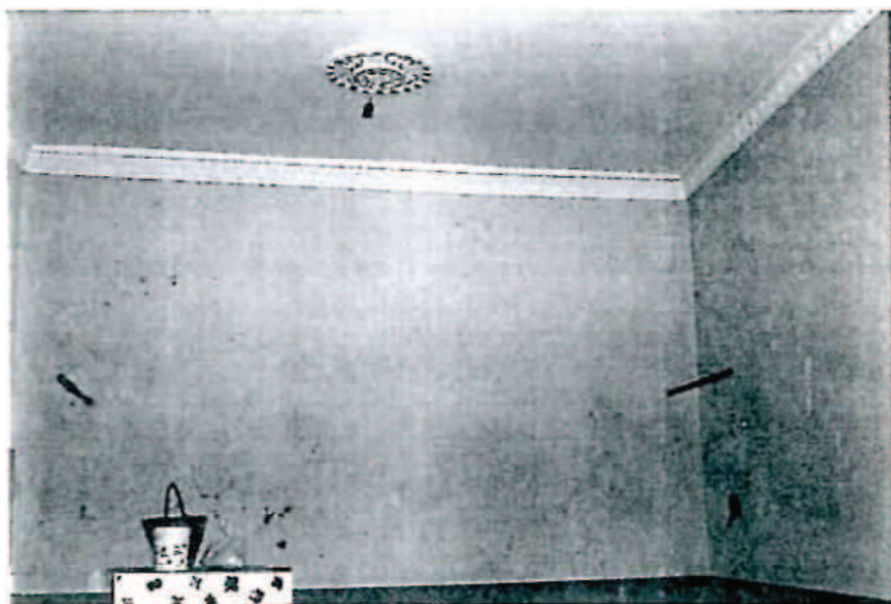
Espace aménagé au métier à tisser dans les nouvelles habitations. Des piquets en fer scellés dans le mur pour soutenir le métier à tisser
