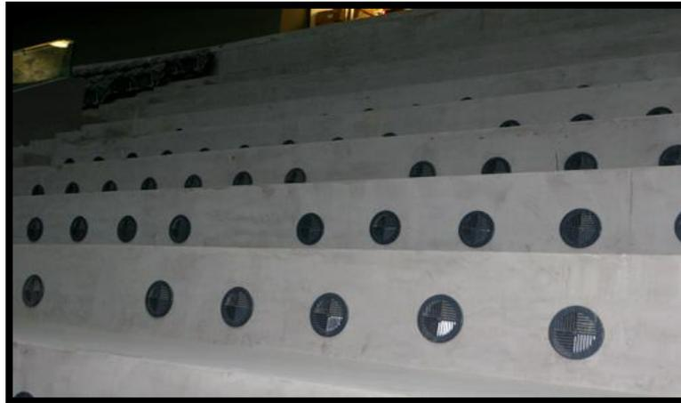
Figure 142 : les bouches d'aérations au niveau des gradins. Source : archdaily.
