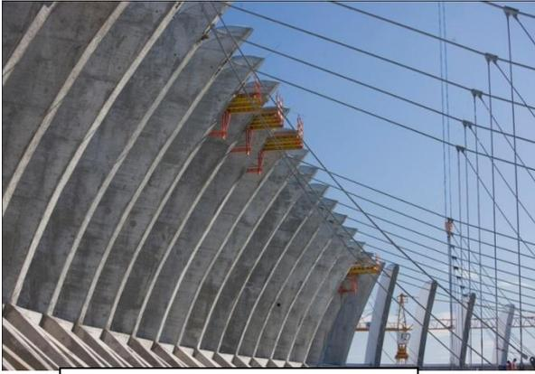
Figure 85 : les colonnes de béton précontraint. Source : archdaily.
