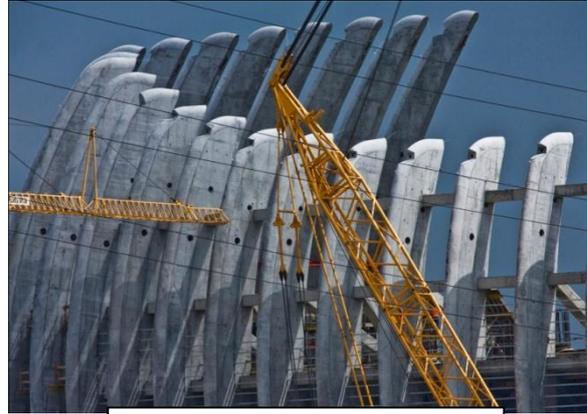
Figure 84 : les colonnes de béton précontraint. Source : archdaily.
