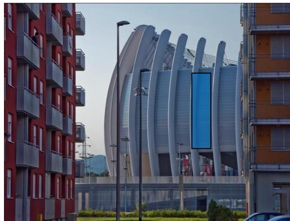
Figure 83 : enveloppe en polycarbonate semi-translucide . Source : archdaily.
