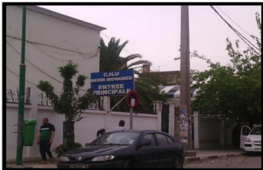
Figure 32 : L'hôpital de Tizi-Ouzou (BOUTALEB et LECHEHEB, 2019).
