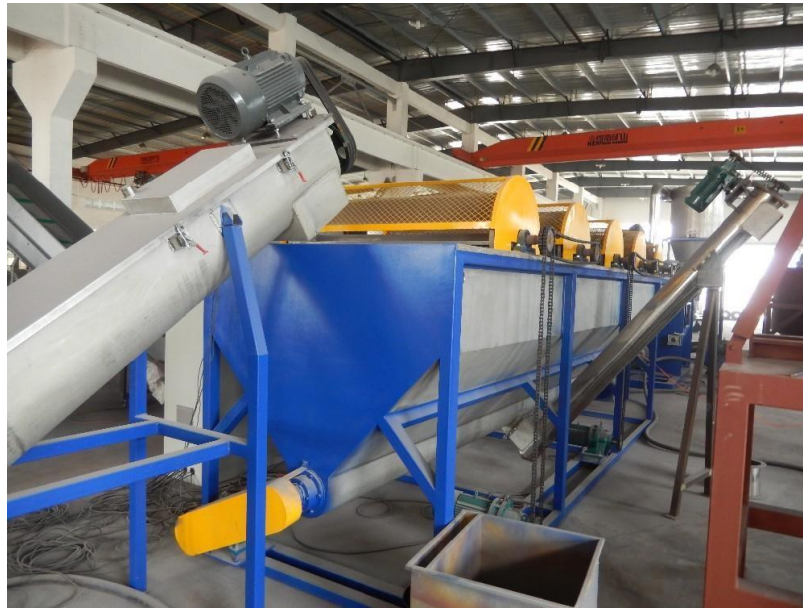
Figure IV-12 : Exemple du Bac horizontal
