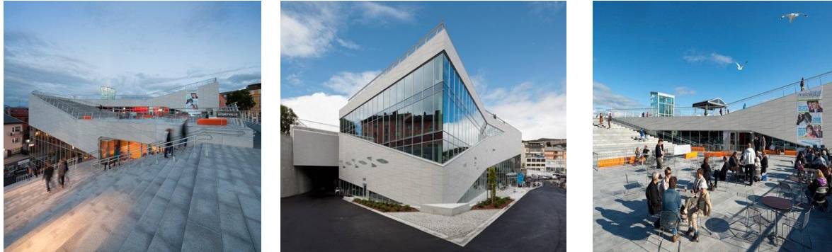
Figure 164 : revêtement des murs, du toit et de l'escalier
