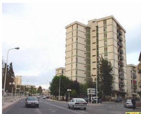
Fig32.vue sur l'avenue Source : Auteurs
