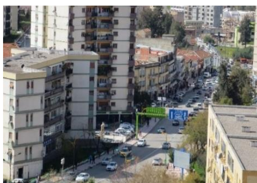
Fig.26.vue sur l'ensemble du quartier Source : Auteurs
