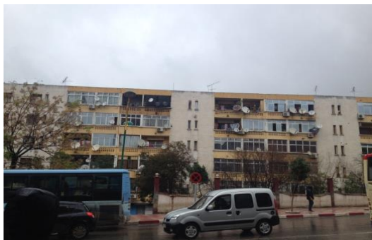
Fig.118.Façades Avant la réhabilitation réhabilitation
