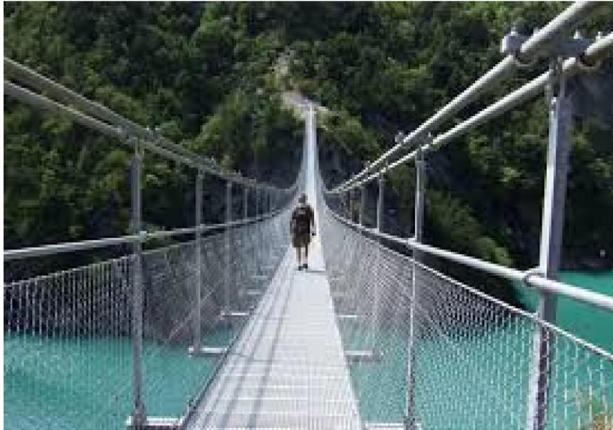
Figure 1-7: Passerelle piétonnière suspendue rigidifiée par des câbles précontraints
