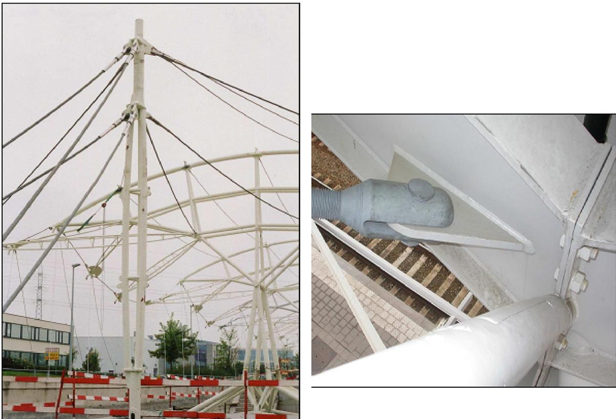
Figure 1-2: Structure de la toiture suspendue de la station du métro Erasme à Bruxelles
