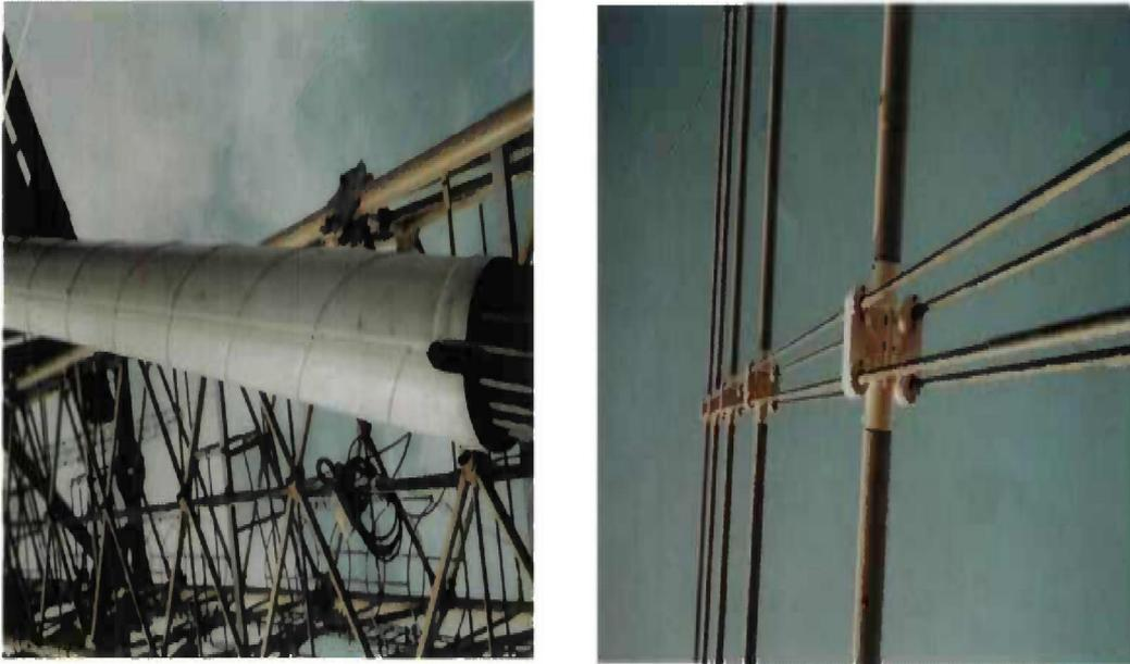
Figure 2-11: Gains profilées et aiguilles du pont de Normandie
