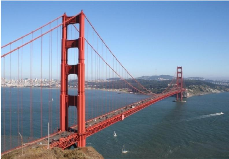
Figure 1-5: Pont du Golden Gate, San-Francisco ; Californie ; Longueur totale : 2737 m ; Portée principale: 1280m ; Hauteur: 230 m ;
