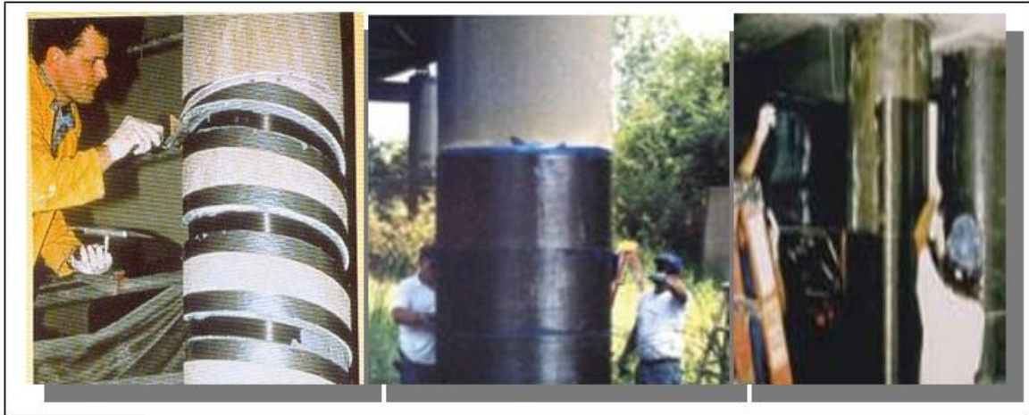
Figure II.3: Confinement des poteaux par stratification directe. [27]
