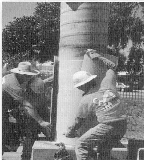
Figure II.5: Confinement des poteaux par coquille PRF préfabriquée.[9].
