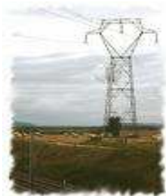
Figure-I-1 Pylône d'ancrage
