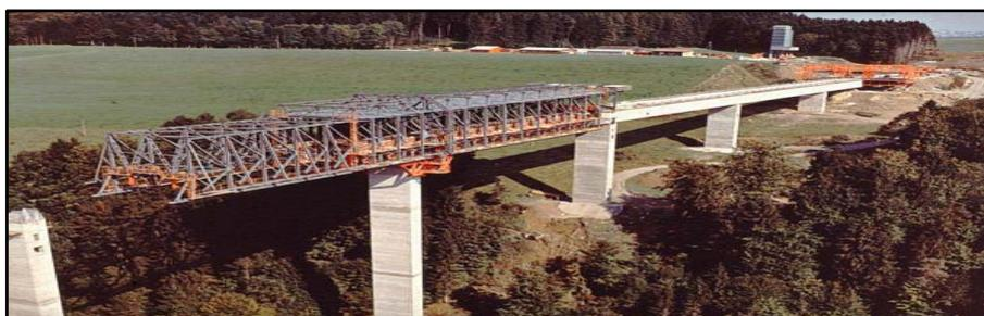
*Fig. II.5 : Construction par poussage*
