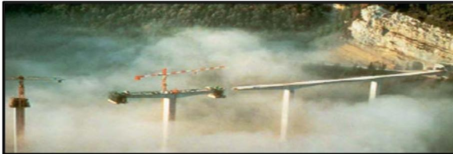
Fig. II.7: Construction par encorbellement
