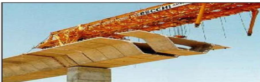
*Fig. II.10 : Pose des voussoirs préfabriqués.*
