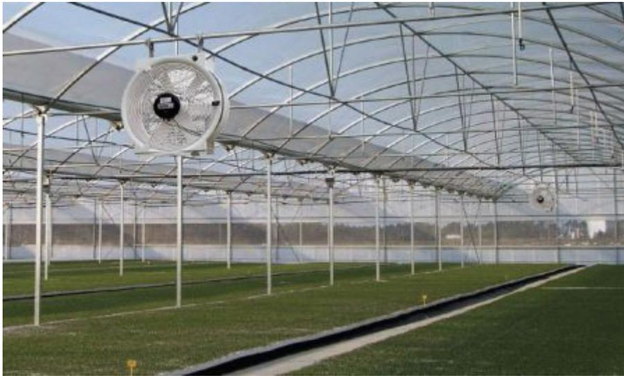
Figure 14: Brasseur d'air dans une serre
