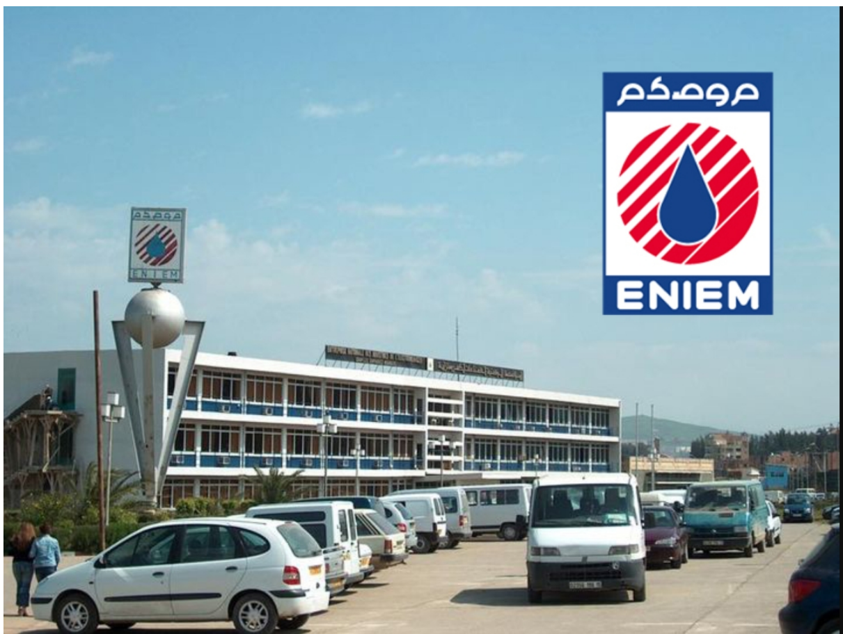
FIGURE 1 – Entreprise d'accueil Eniem ,Tizi-Ouzou
