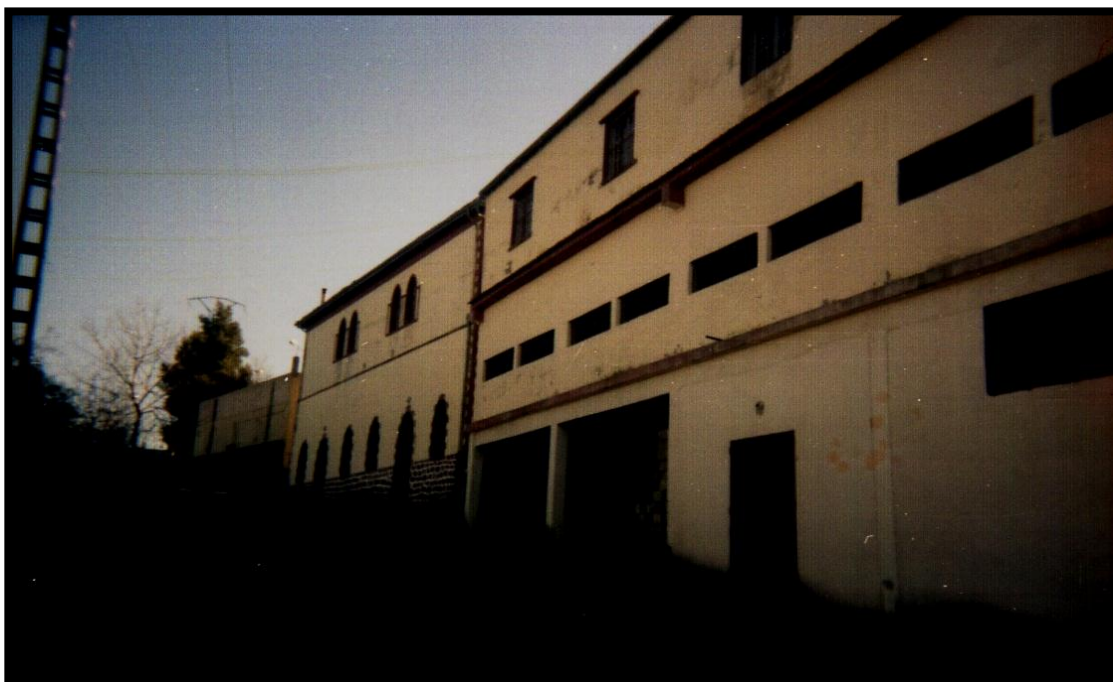
Figure N°40 : Le bloc qui abrite la cuisine du sanctuaire et le makhzen.
