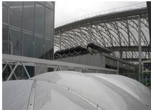
Figure 256: Toiture en ETFE du centre commercial et de loisir de Confluence de Lyon.
