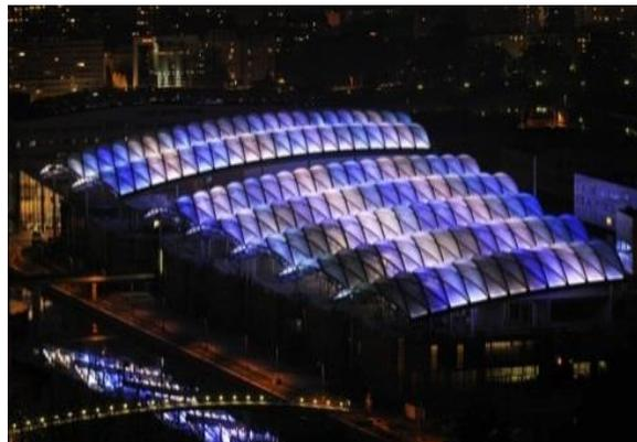
Figure 253 : La toiture en ETFE du centre commercial et de loisir de Confluence de Lyon la nuit
