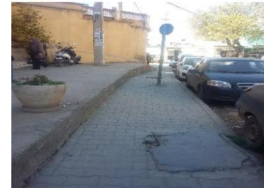
Figure 28 : la dégradation de trottoir
