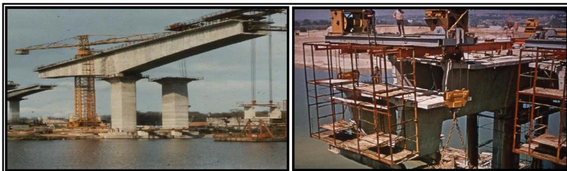
**Fig. I.5. Pose avec un équipage de levage autonome.**
