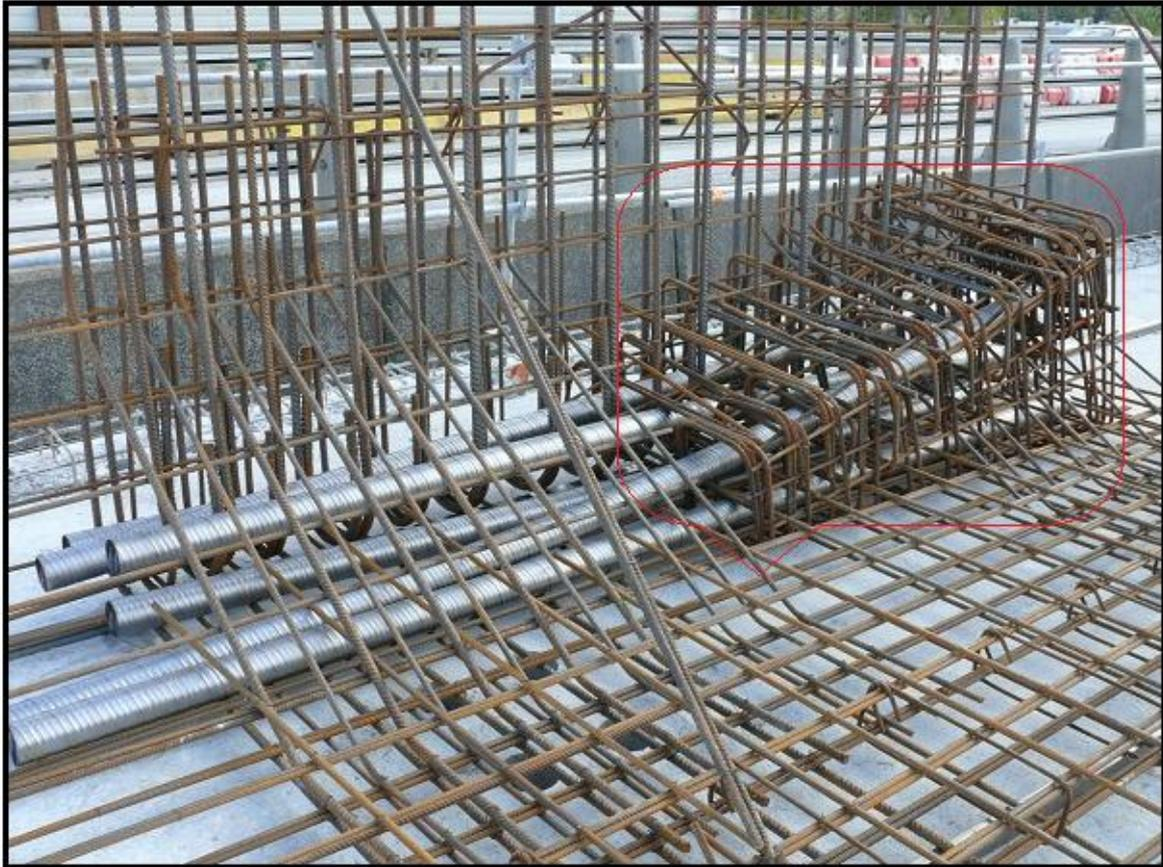
**Fig. VIII. 14 : ferrailage d'un bossage dans un voussoire**
