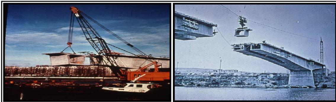
**Fig. I.4. Pose à l'aide d'une grue et d'un blondin.**
