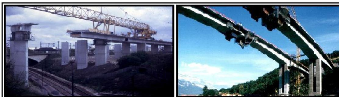
**Fig. I.13. Construction par encorbellement.**
