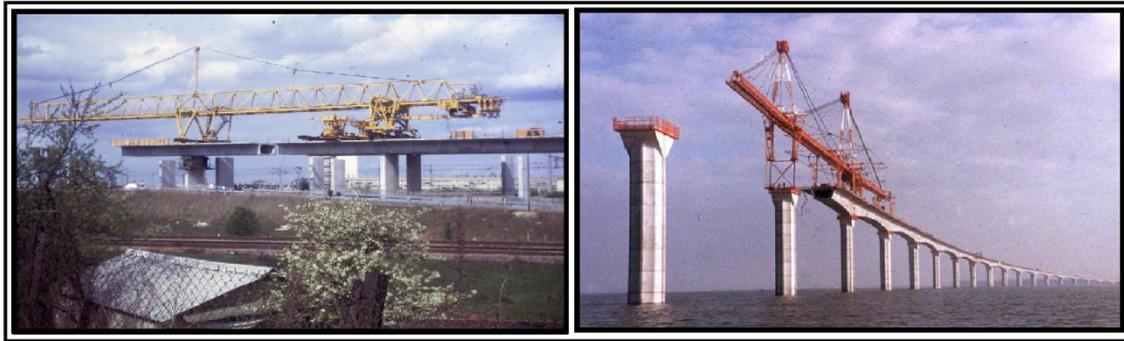
**Fig. I.6. Pose avec une poutre de lancement.**
