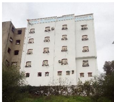
Figure 55 : Vue sur lotissement Hesnaoua Source : Prise par les auteurs en 12/2016
