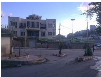
Figure 60 : Vue sur la DJS de Tizi-Ouzou Source : Prise par les auteurs en 12/2016
