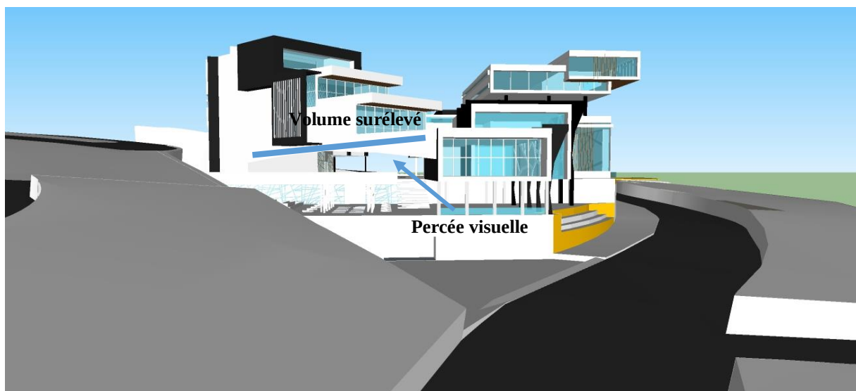
Figure 180: Vue sur le volume réalisé en structure métallique. Source: Elaboré par les auteurs.
