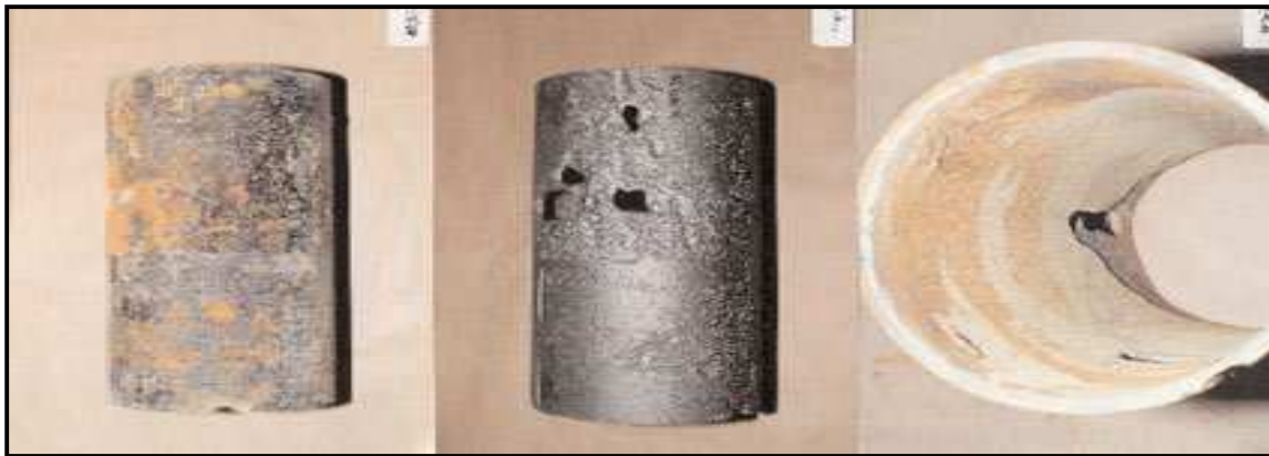
Figure V-1) : Corrosion des conduites en fonte
