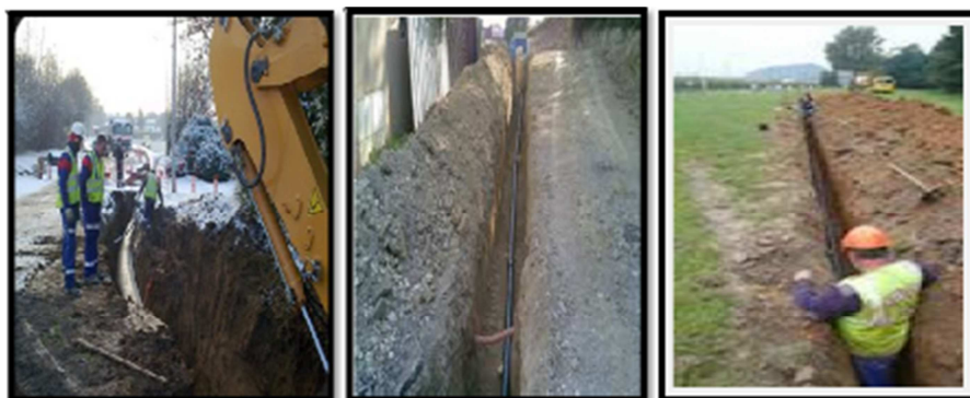
Figure VI-1): Pose des conduites en terre
