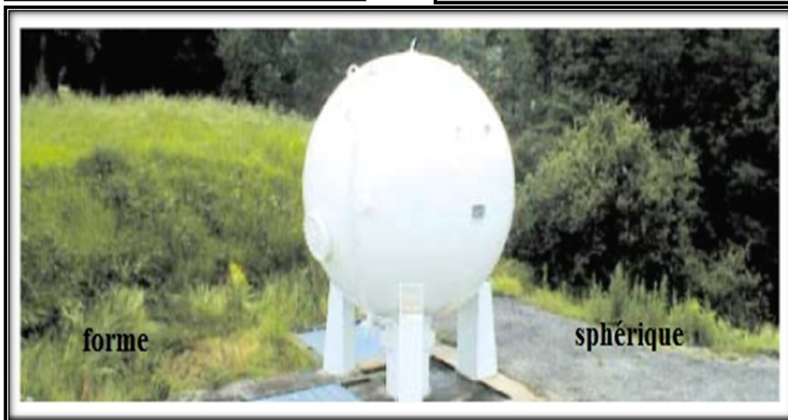
Figure IX-8) : Les différentes formes de réservoirs anti-bélier
