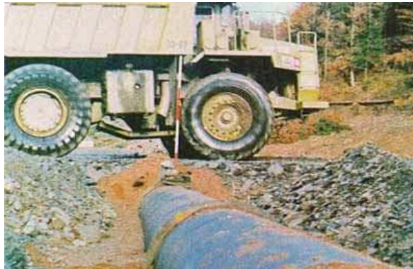
Figure VI-3) : Traversée d'une route
