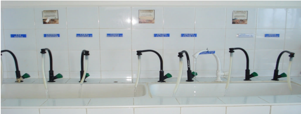
Figure 17: Différents robinets sur lesquels s'effectuent les prélèvements aux niveaux de laboratoire (Taksebt).
