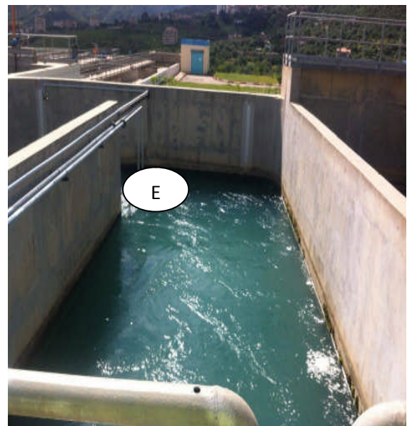
Figure n°13 : Injection de l'acide Sulfurique.
