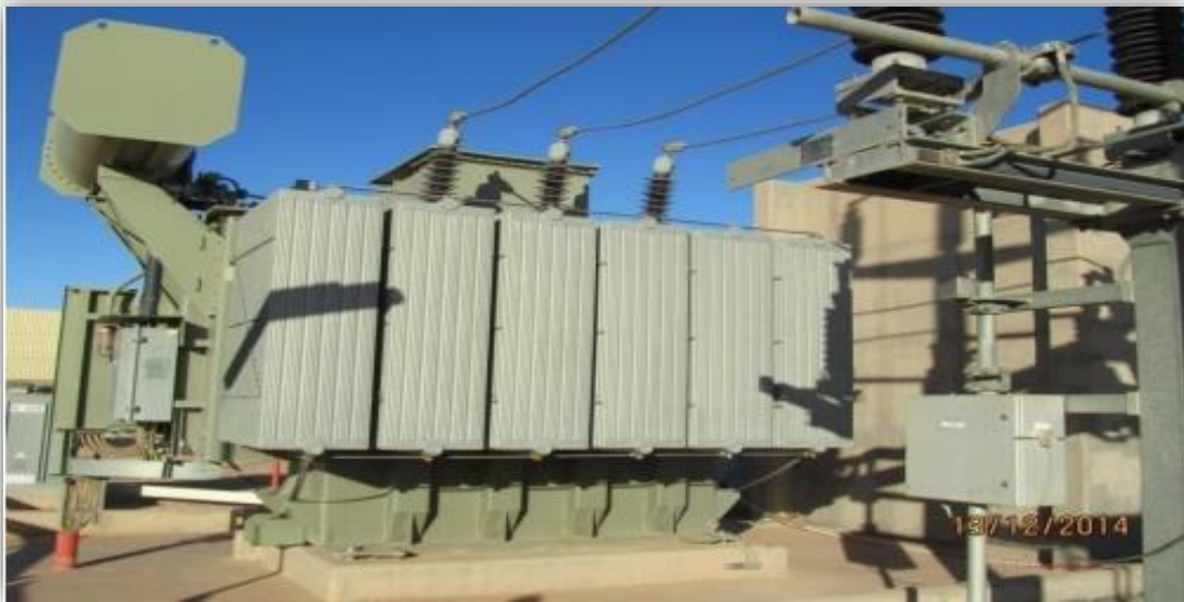
Figure I.9: La cuve d'un transformateur de puissance.
