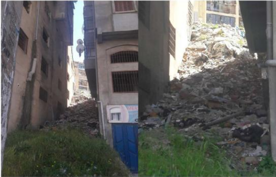
Figure 2: Déchets de démolition au sein du quartier les 600, nouvelle-ville de Tizi-Ouzou
