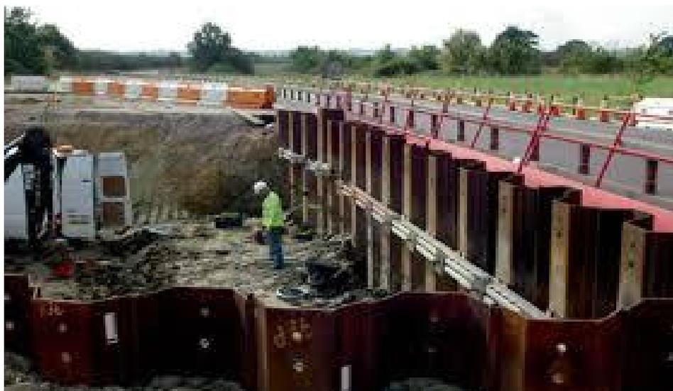
**Figure III-12 ouvrage de soutènement en palplanche**
