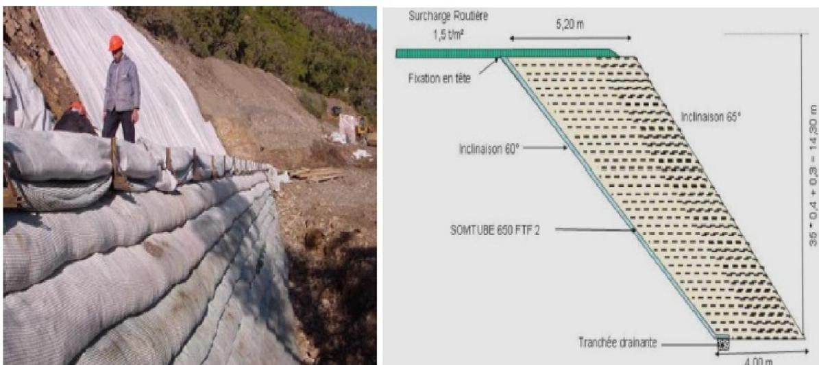
**Figure III-16 positionnements des nappes géotextile**
