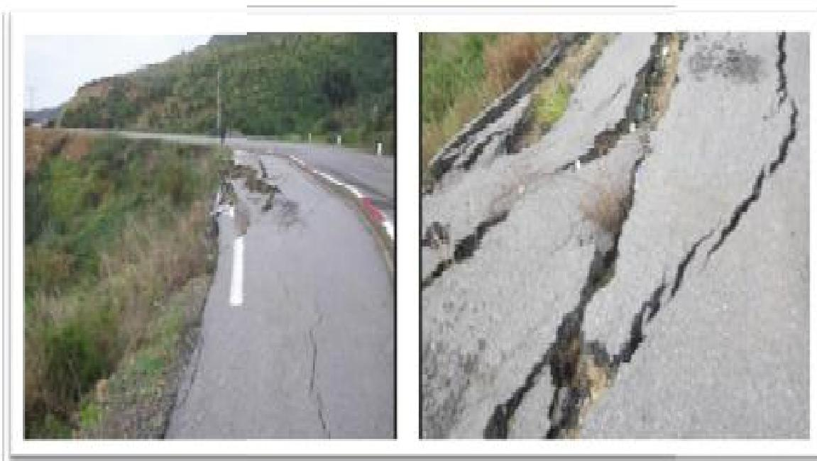
**Figure IV-3 : Fissures et ruptures sur la chaussée (photo prise en 2016 - DTP de Bejaia)**
