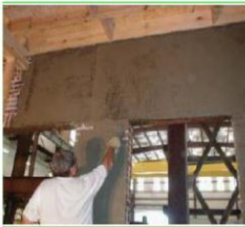
Figure I.9: Renforcement des murs par les composites TRC.
