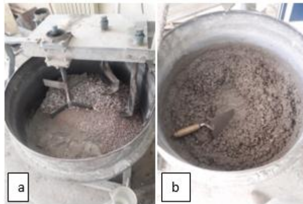
FIGURE II.11 : Confection du béton .
