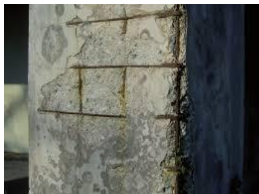
Figure I.3 : corrosion d'armatures.
