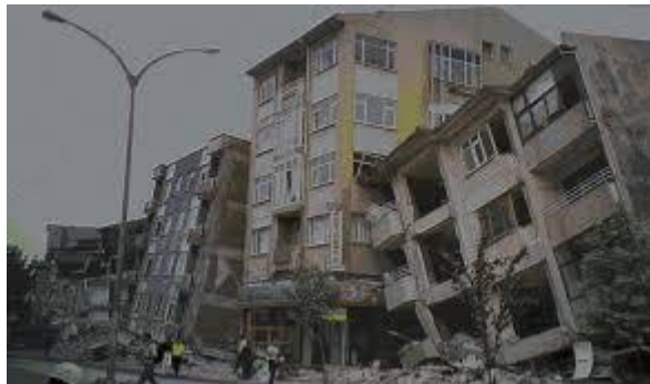
Figure I.2 : dégâts d'un séisme.
