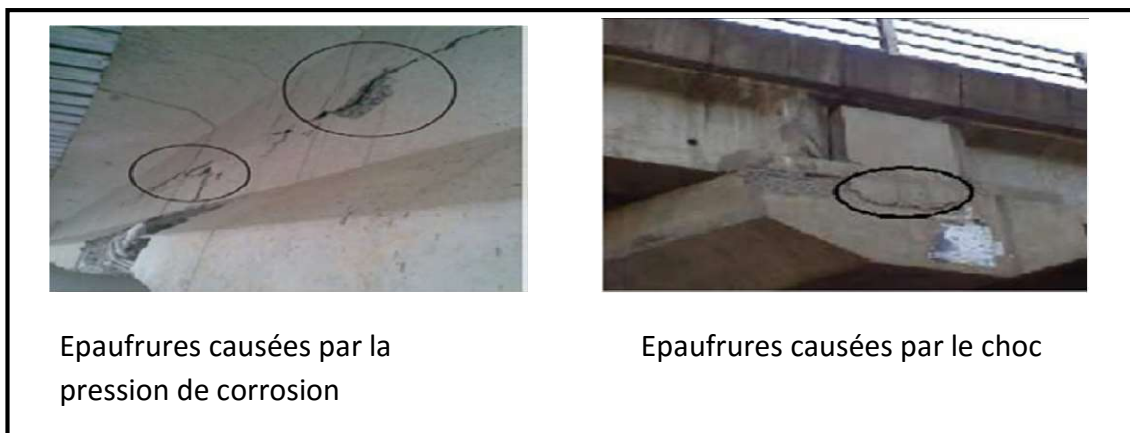
Figure I.8 : Les épaufrures
