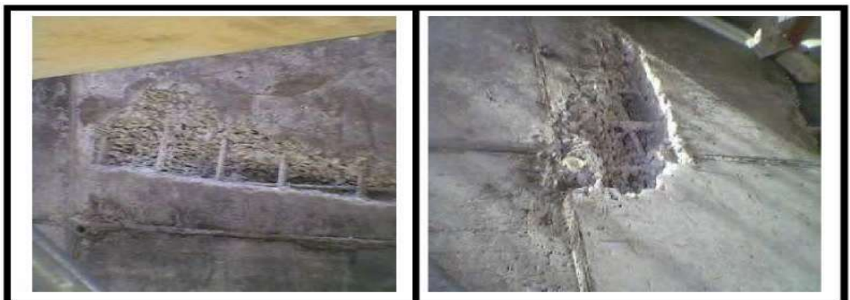
Figure I.11 : Ségrégation des éléments de béton
