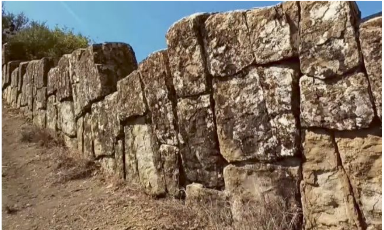
Mur Ujahli à Boudjima (Ahriq)
