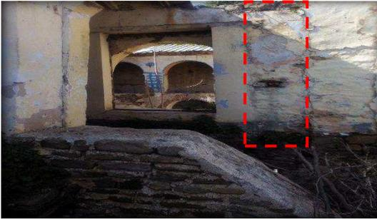
**Figure 129 :** fissuration ponctuelle au niveau du mur dues à une mauvaise répartition des charges de la toiture
