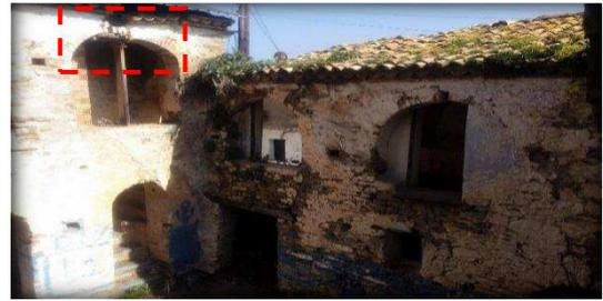
**Figure 126 :** Effondrement partiel de la toiture sous effet du séisme.
