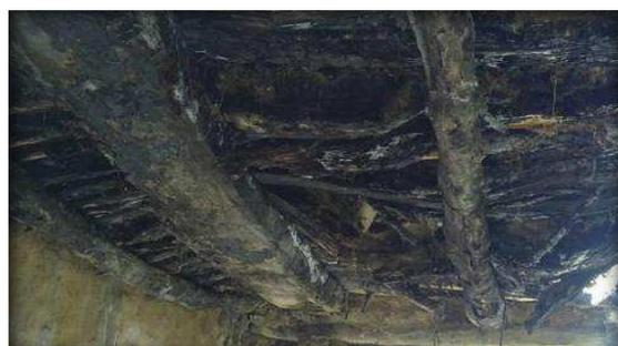
**Figure 136 :** Pourrissement du plancher sous l'effet de l'humidité
