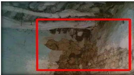
**Figure 133 :** Dégradation de l'enduit en terre sur la pierre sous l'effet de l'humidité
