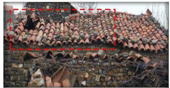
Figure 124 : soulèvement et cassure des tuiles sous effet du vent
