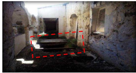
**Figure 132 :** fléchissement et rupture du plancher dues aux différentes sollicitations extérieures
