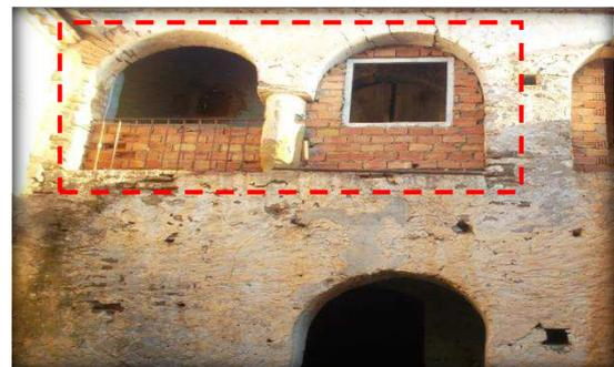
**Figure 139 :** Intervention sur l'existant par de nouveaux matériaux (brique, mortier et tôle...)
