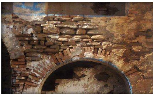
**Figure 140 :** Dégradation et d'écoulement du mortier en terre entre les pierres sous l'effet des intempéries
