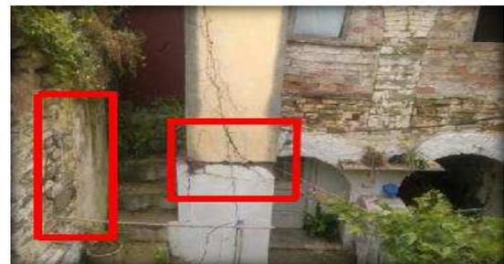
**Figure 128 :** Fissures horizontales et verticales (sous effet du tassement).
