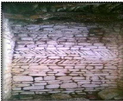
**Figure 109 :** Vue sur un mur d'appareillage en épi traditionnel.
