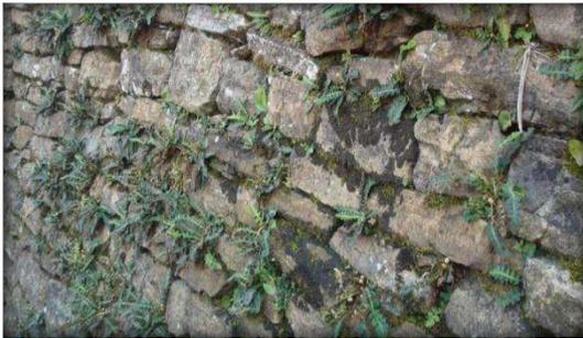
**Figure 137 :** Envahissement de la maçonnerie par les lichens et les mousses.
