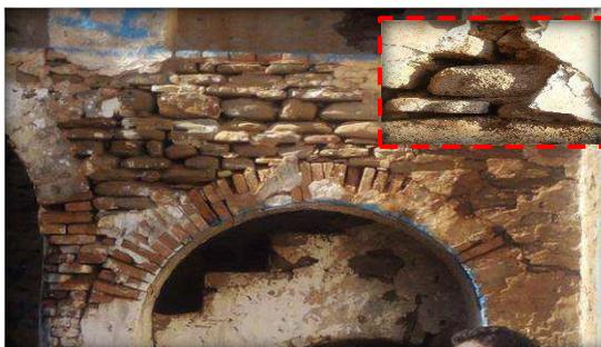
**Figure 135 :** Dégradation du mortier en terre sur la pierre sous l'effet des intempéries
