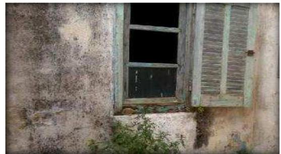
**Figure 134 :** Dégradation de l'enduit et de la boiserie sous l'effet de l'humidité
