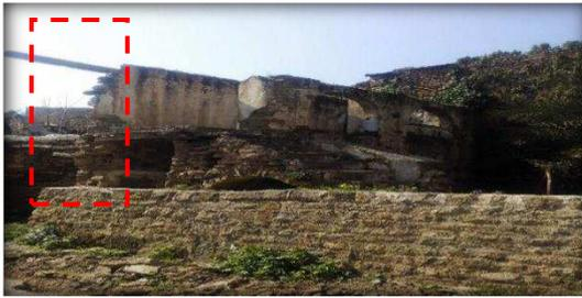
**Figure 125 :** effondrement total du mur sous effet du séisme.
