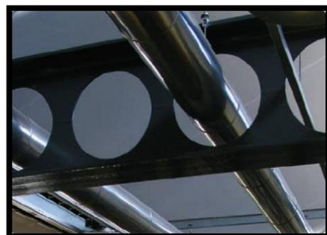
Fig. 110 : représente la poutre alvéolaire,
