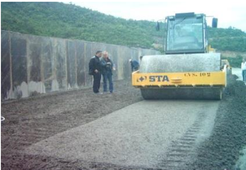
Figure (I.10). Etat du BCR frais lors de son déversement (Barrage Errmil Tunisie) [Belaïd M., (2004)]
