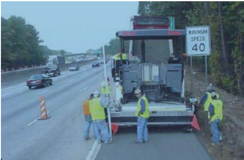
Figure (I.12). Mise en place du BCR en pavage - Atlanta USA [Site Web Association Canadienne du ciment, http://www.cement.ca ]
