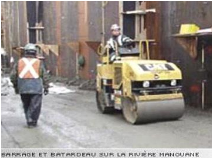
Figure (I.11). Barrage et Batardeau en BCR sur la rivière Manouane au Canada [Site web de Ciment de Québec, http://www.BCR.CC.html ]
