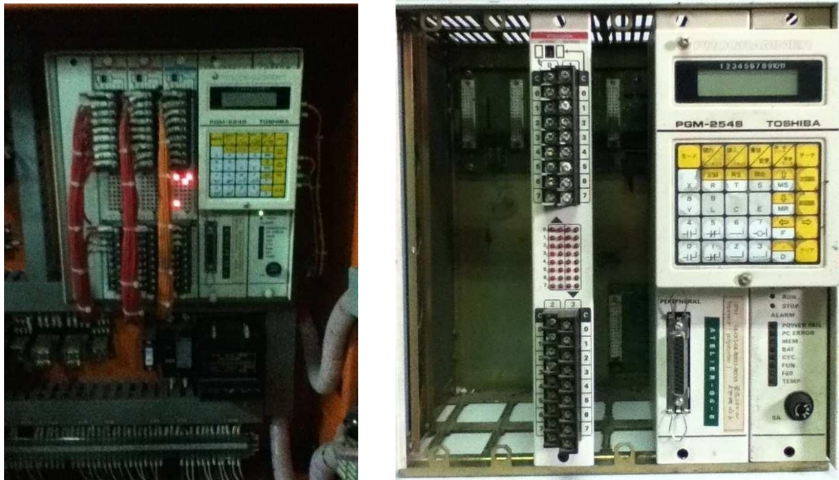
Figure II.8: Image photographique de l'automate (Toshiba) assurant la commande de l'expandeur.
