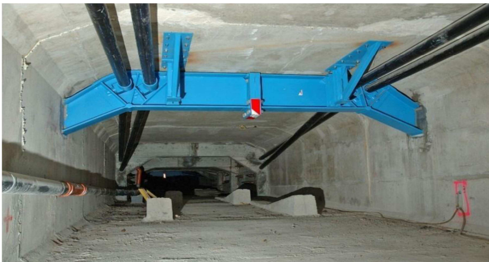
Figure II.3 : Précontrainte additionnelle.
