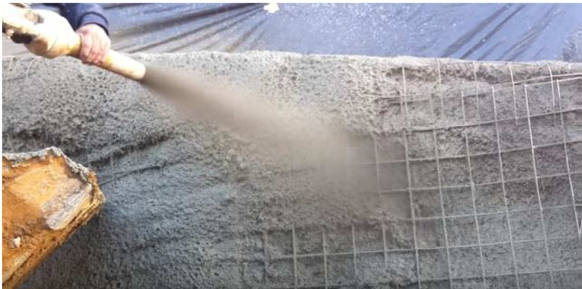
Figure II.4 : Technique de béton projeté.
