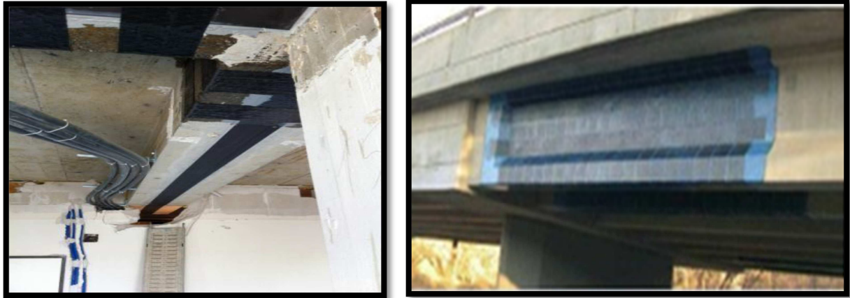
Figure II.7 : Poutres renforcés par des matériaux composites [27].
