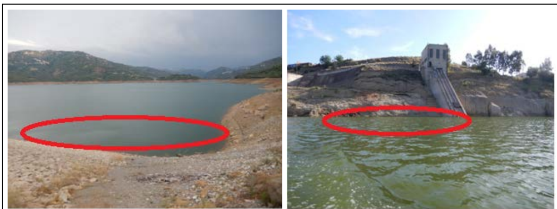
Figure 24: Station 07, au niveau de la digue et la tour de prises d'eau.
