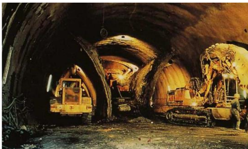
Figure 1.4. Creusement en section divisé.
