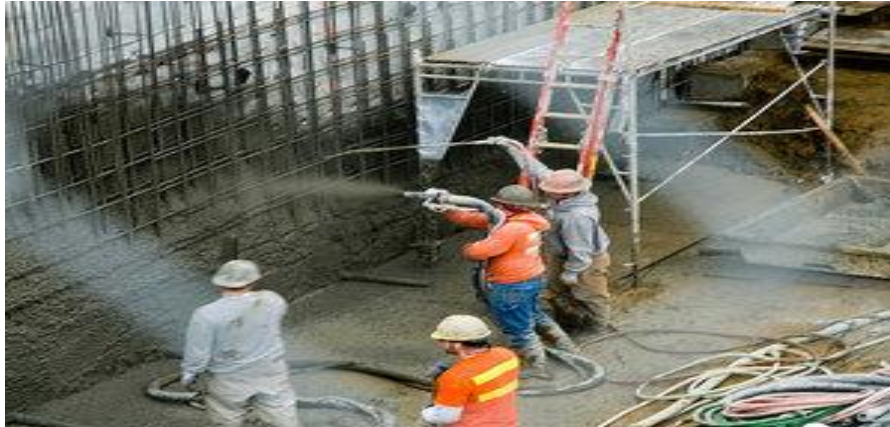
Figure 1.15. Illustration d'un béton projeté.
