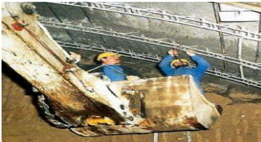
Figure 1.21. Mise en place des cintres réticulés.
