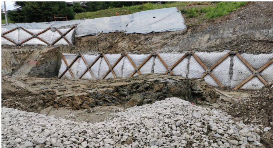
Figure 1.16. Soutènement par écrans cloués.
