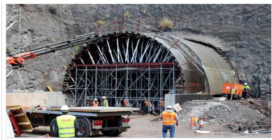
Figure 1.18. Soutènement en béton armé.
