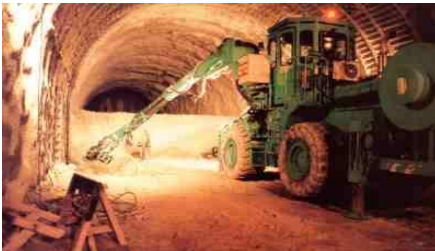
Figure 1.6. Creusement en demi-section.
