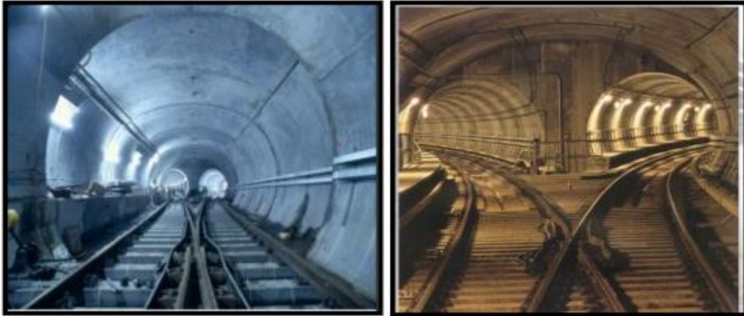
Figure 1.1. Différentes formes de section transversale du tunnel.
