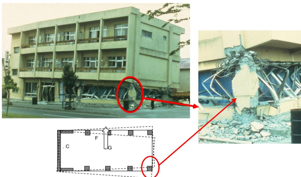
(Figure I.10) : Plastification d'un poteau d'angle due à la disposition asymétrique des voiles.
