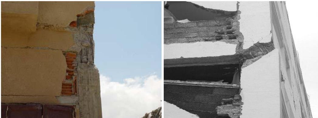
**Figure I.6 :** Eclatement de la zone nodale du à la poussé diagonale de la maçonnerie.
