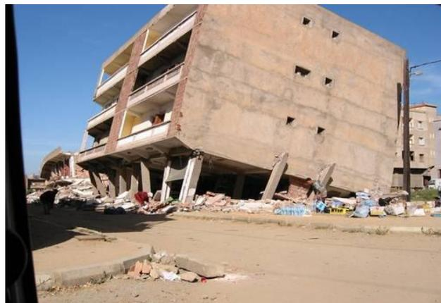
**Figure I.7 :** Effondrement de la structure sur le RDC.
