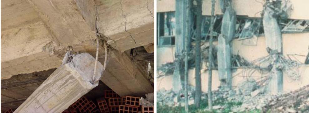
Figure I.3 : Plastification des poteaux avant les poutres.
