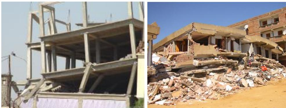
**Figure I.2 :** Effondrement de structures dues a des déplacements importants.
