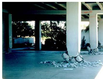
(**Figure I.9**) : Plastification des poteaux.
