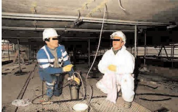
*Figure.I.21 réparation des fissures sous un pont [4]*
