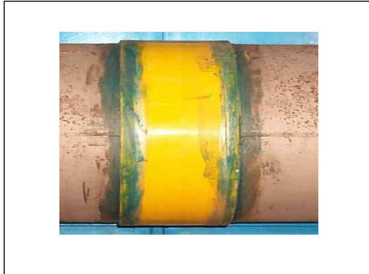
*Figure.II.10 réparation par ressorts d'horloge [10]*
