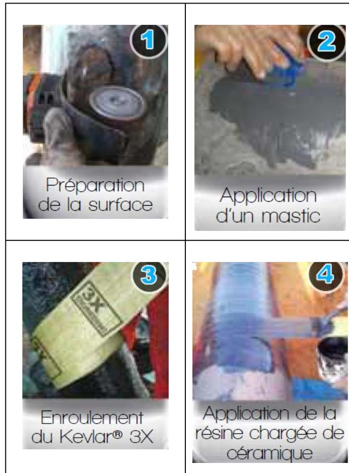
*Figure.II.15 Réparation composite pour canalisations corrodées [12]*
