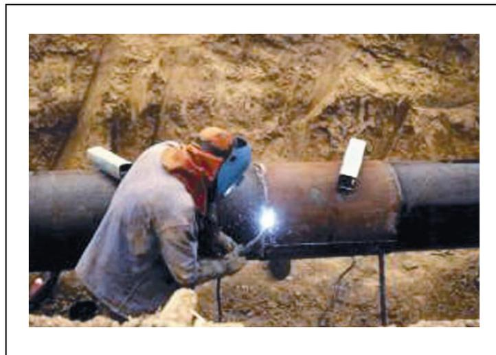
*Figure.II.5 opération de soudage d'une demi-coquille sur un pipeline corrodé [11]*
