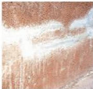
Calfeutrage de fissures à l'aide d'un mortier à base de liants hydrauliques
