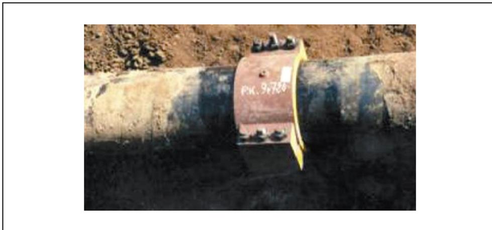
*Figure.II.13b vue en plan d'un demi-manchon boulonnée pour arrêter la fuite de gaz [11]*
