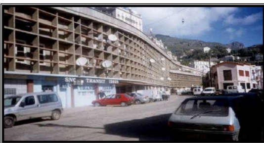
Figure37 : La rampe du port
