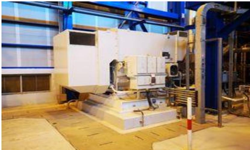
**Figure (I.11)** : Photo réelle de la pompe d'alimentation (LAB10AP001)
