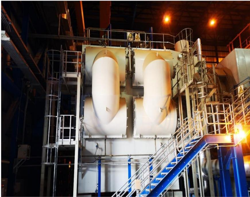
Figure (I.8) : Vue de l'extérieur du condenseur (MAG10AC001)
