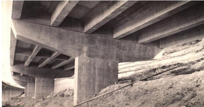
**Fig. I-5-Pont a poutre**
