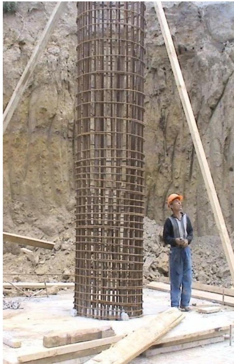
**Image XI.2- mise en place du ferrailage du fut.**
