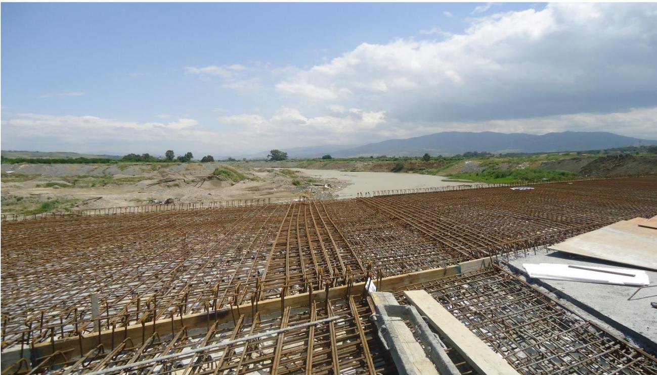
**Images V.1 : Dalle de compression d'un pont**
