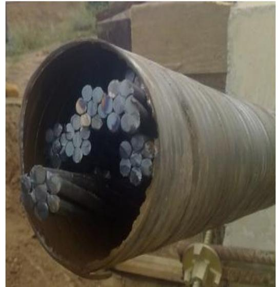
Image VII.1 : armatures passif et active de la PP
