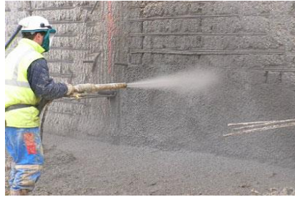
Fig.I.10 : Renforcement au moyen d'un béton projeté [26]
