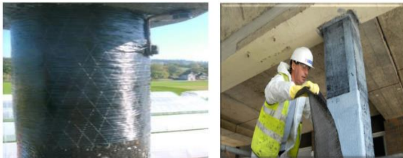
Fig.I.19: Poteaux en BA confinés par matériaux composites.
