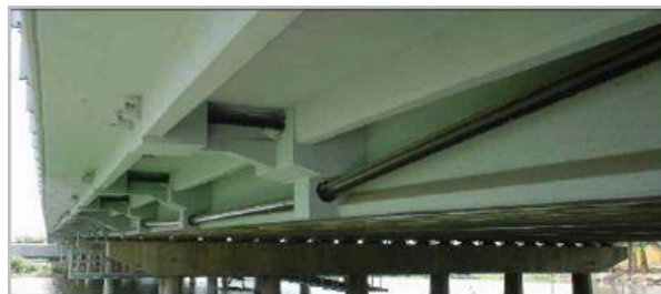
Fig.I.11 : Gaine de précontrainte additionnelle avec déviateur. [26]
