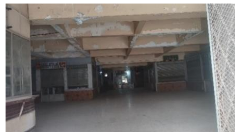
Figure 91: l'état actuel de bâtiment d'ancienne gare source : auteur
