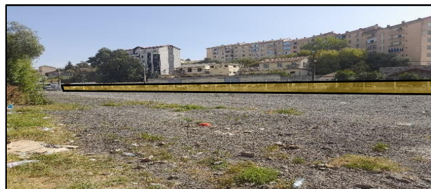
Figure 121: Absence d'aménagement et du mobilier urbain Source : auteur le 3/11/2024
