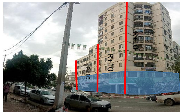
Figure 32: bâtiment EPLF au long de la voie LARBI BEN MHIDI source :auteur
