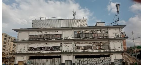
Figure 33: bâtiment ancienne gare source: auteur
