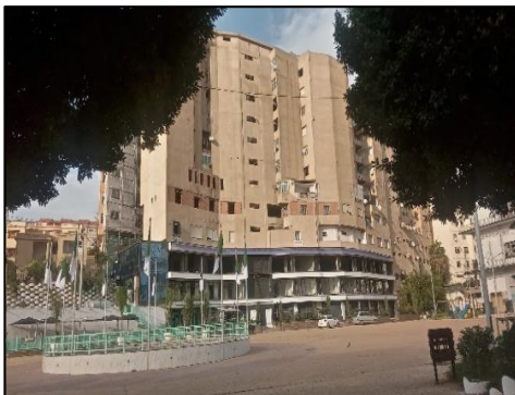
Figure 177:la coopérative avant la requalification ,source :auteur
