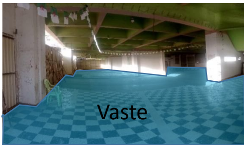
Figure 94: le plancher en caisson qui permet de réalisé des vaste espace comme le cas de bâtiment ancienne gare source : auteur
