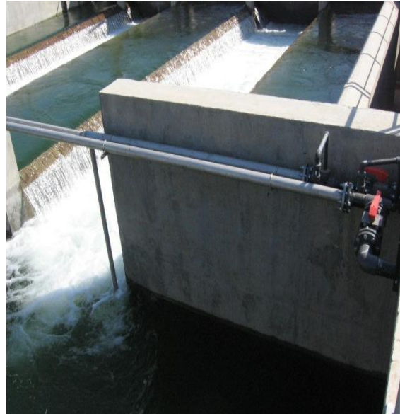
Figure 3 : Injection de Cl 2 en pré-chloration Figure 4 : Permanganate de Potassium
