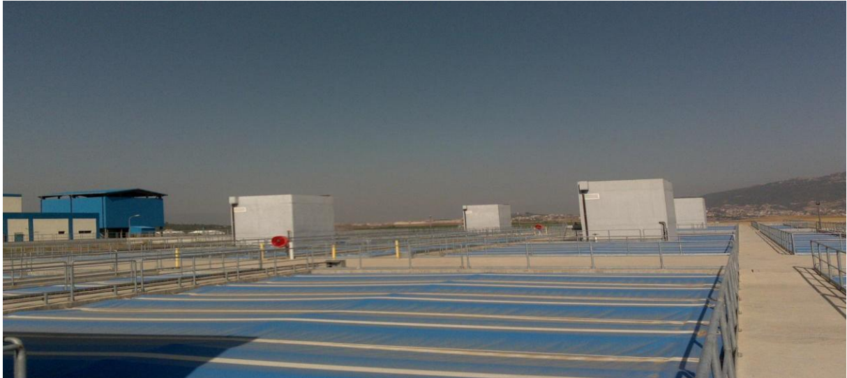
Figure 9 : Photos des Décanteurs (Pulsa tube)
