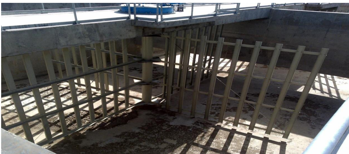
Figure 10 : Flocculateur
