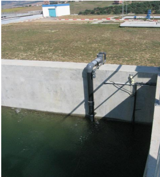
Figure 3 : Injection de Cl 2 en pré-chloration Figure 4 : Permanganate de Potassium
