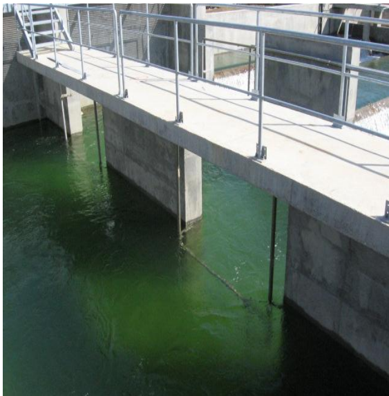
Figure 5 : Injection de CAP
