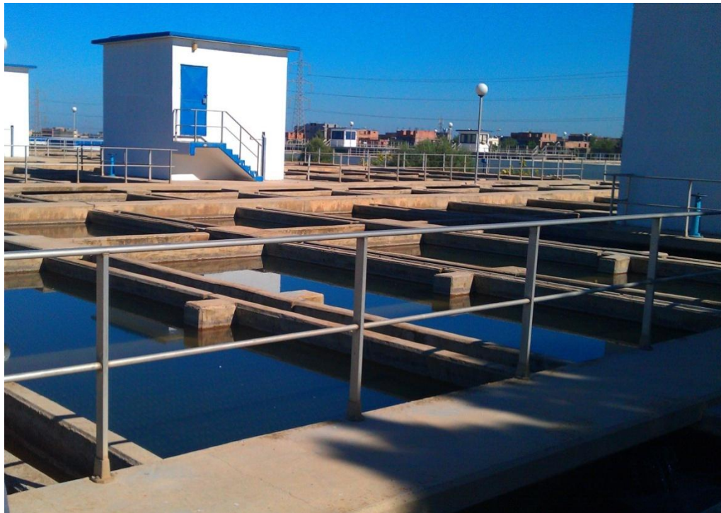
Figure 16 : Décanteur
