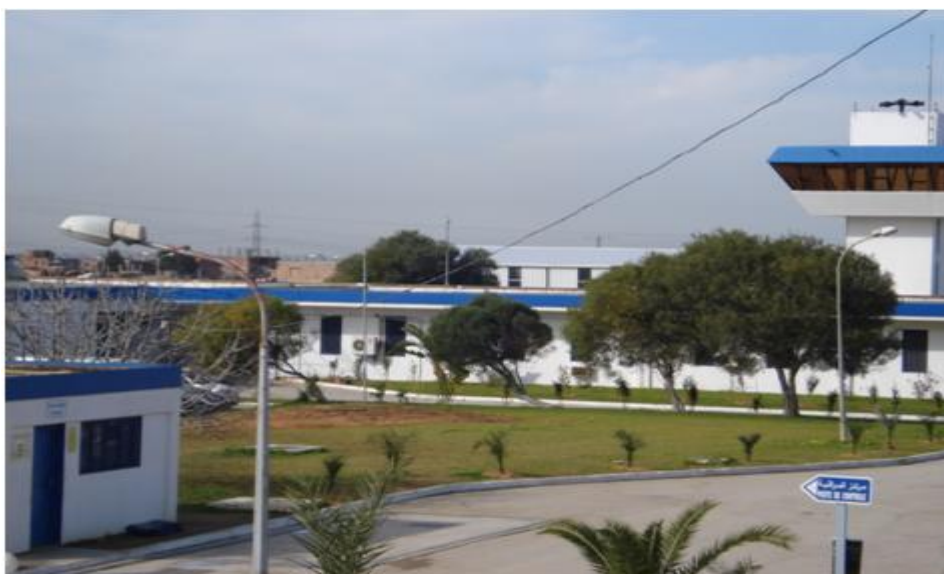
Figure 14 : Station de traitement Boudouaou
