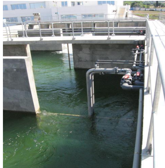
Figure 6 : Injection de Sulfate
