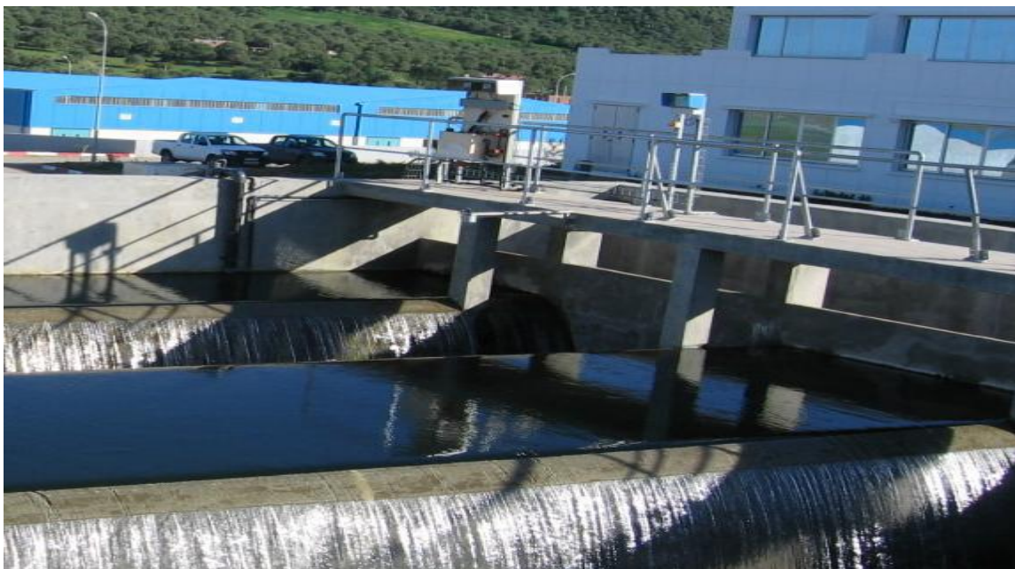
Figure 2 : Chambre d'arrivée de l'eau brute
