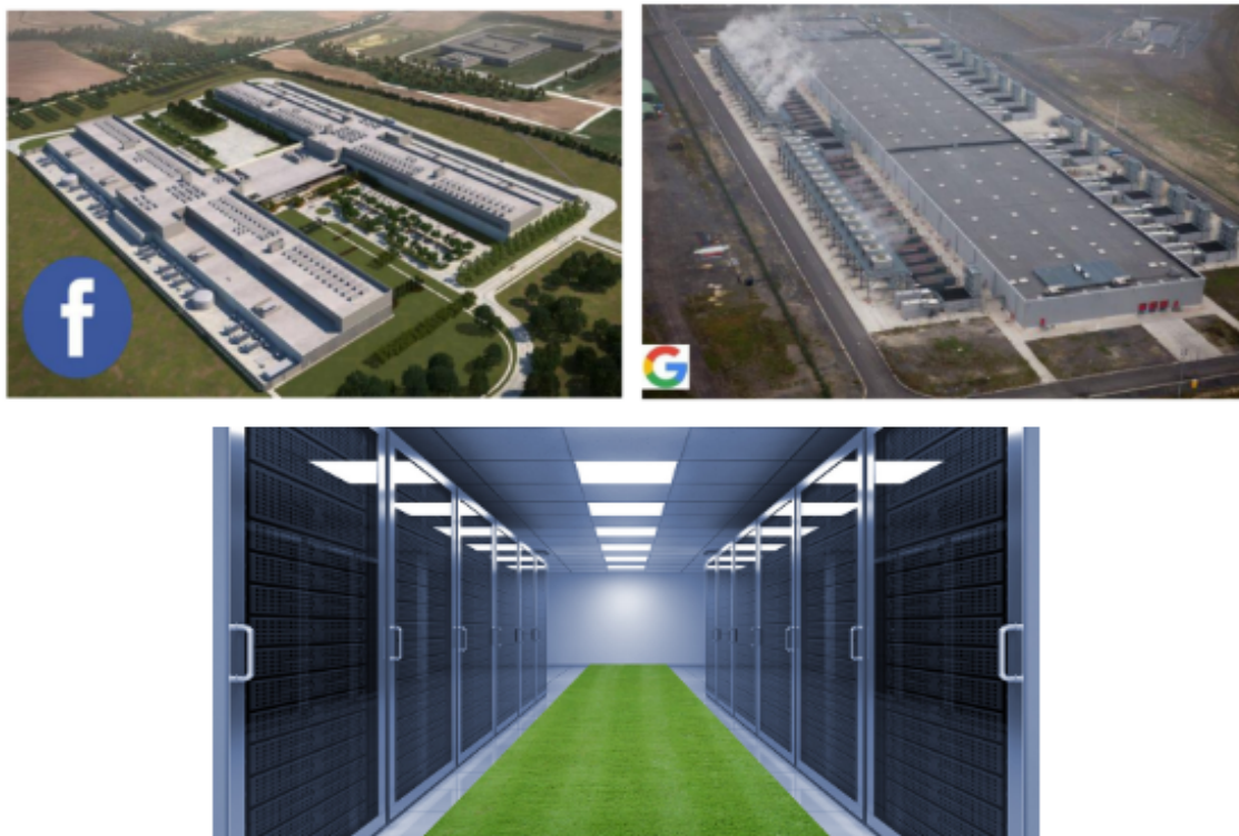
FIGURE 1.5 – Exemple de Data-center de Google et Facebook.
