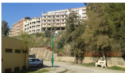
Figure I.36 : Vue sur le talus Source : Auteur
