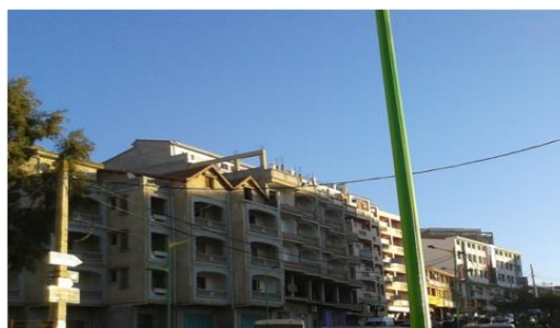
Figure I.42 : Façade de bâtiments situés à la périphérie du site d'étude. Source : auteurs
