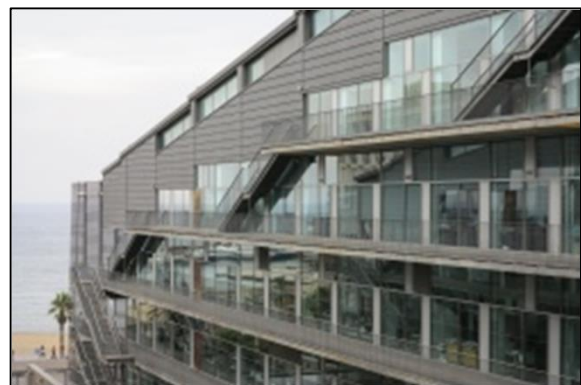
Figure II.18 : façades des étages supérieurs Source : fr.wikiarquitectura.com
