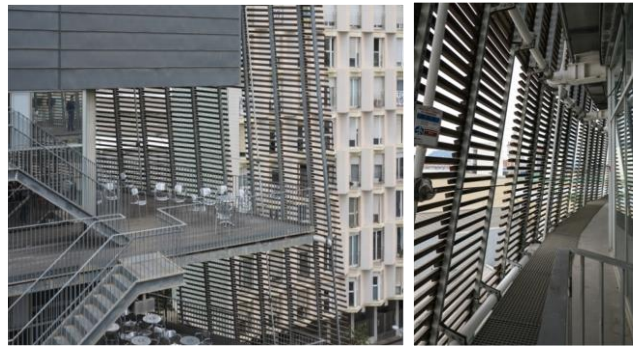
Figure II.22 : Vue sur la façade double peau. Source : fr.wikiarquitectura.com
