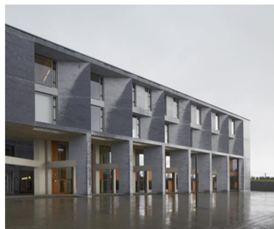
Figure II.35 : vue sur l'une des façades de l'école Source : Google image
