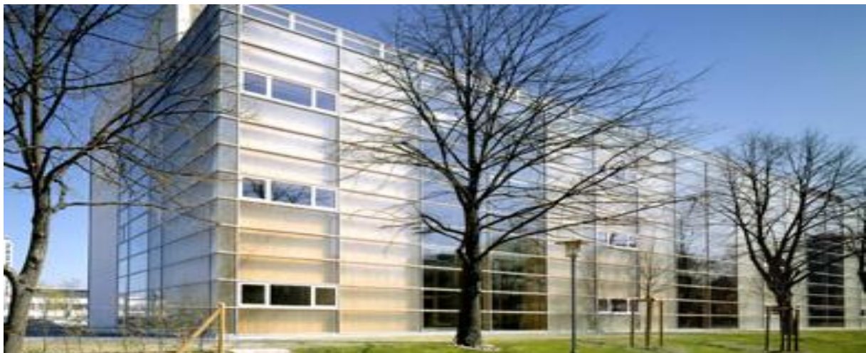
Figure II.23 : Façade sud de l'institut de médecine de Fribourg-en-Brisgau. Source Google images
