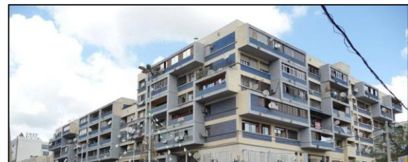
Figure I.10: un bâtiment du type HLM. Source : auteurs
