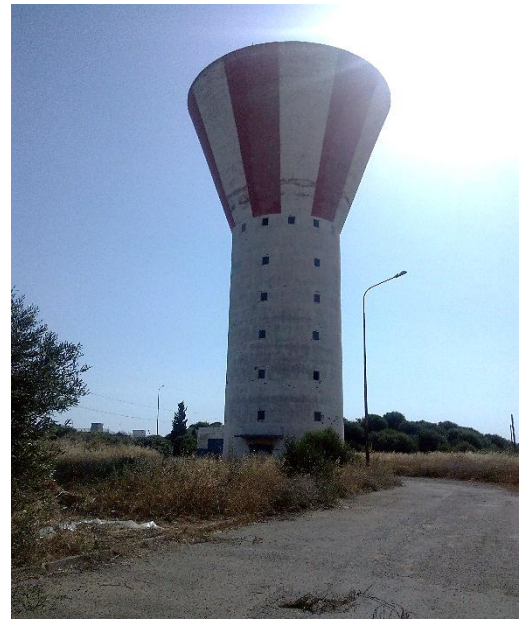
Figure I.15: photo du château d'eau
