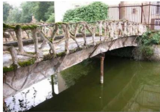
Figure 1.2 : Pont bi-poutres de Chazelet, 1875, Joseph Monier
