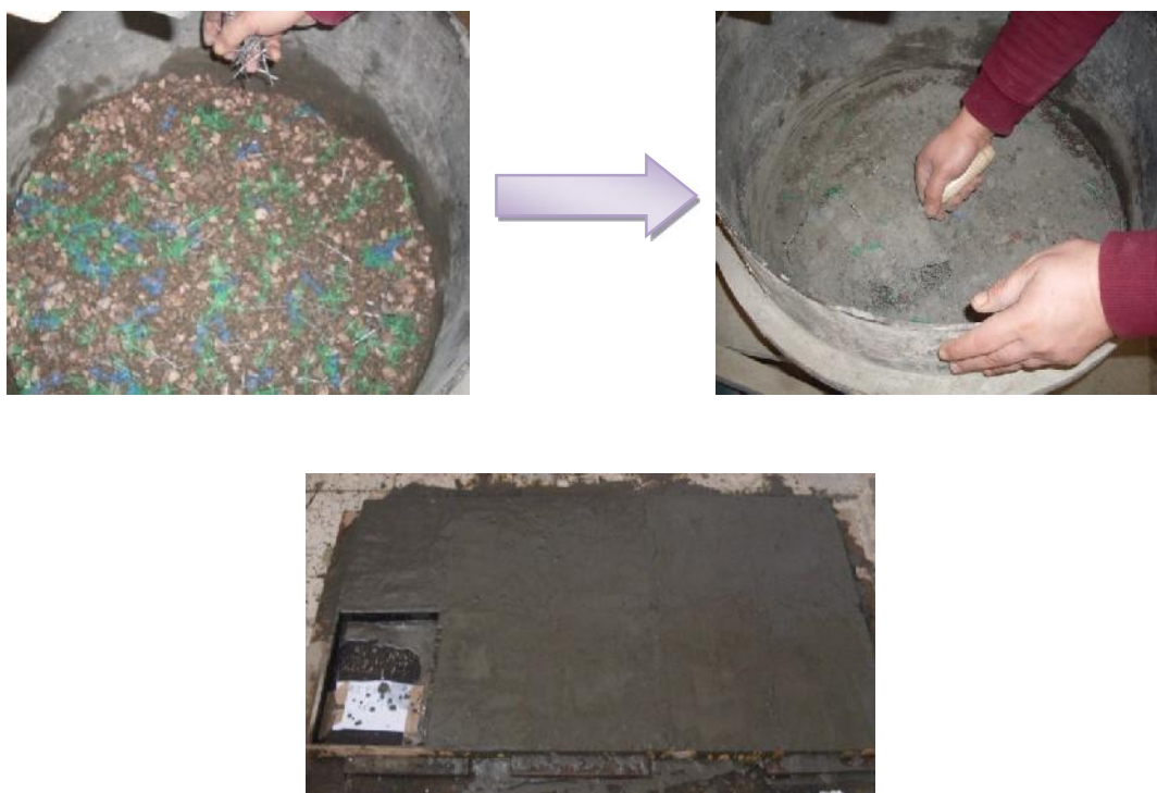
Figure II.12 Réalisation des neufs dalles à fibres variées.
