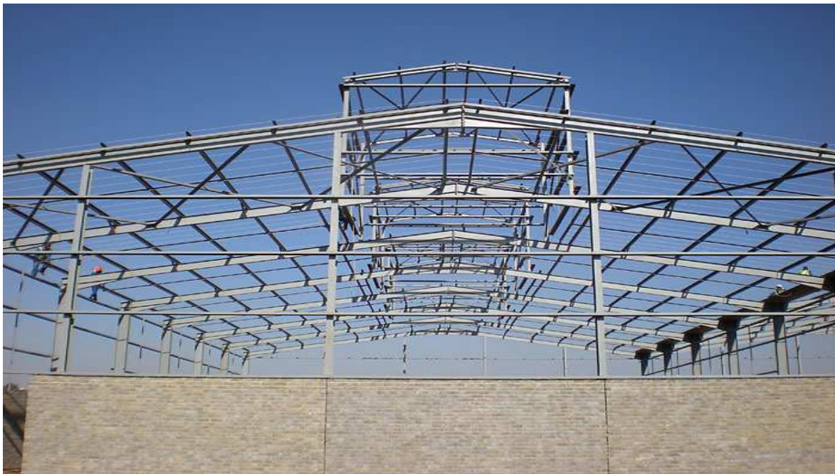
Fig3-IV-exemple de poteaux en acier HEA
