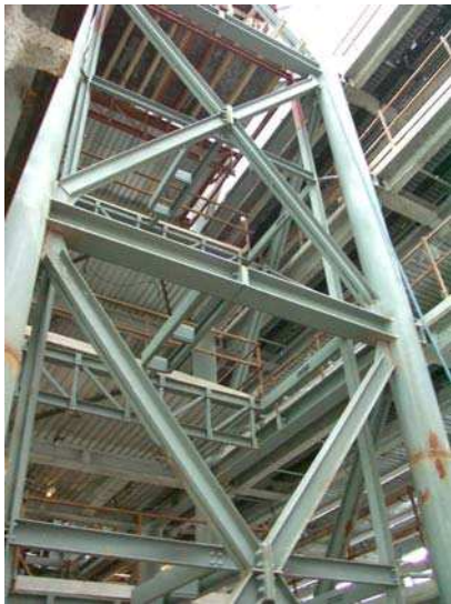
Figure II.13 Chantier du palais de justice de Grenoble (Document P. Balandier) Liaisons rigides sur l'ossature principale et articulées, par faiblesse de la plaque d'assemblage qui peut plastifier rapidement, entre les barres des croix de Saint-André et la structure principale
