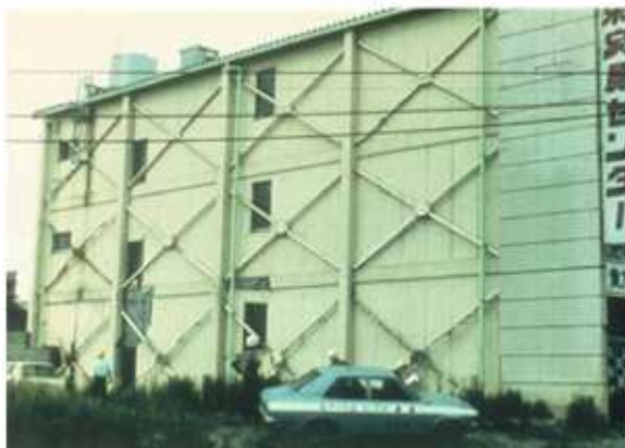
Figure II.11 Exemple des structures à contreventement centré en X
