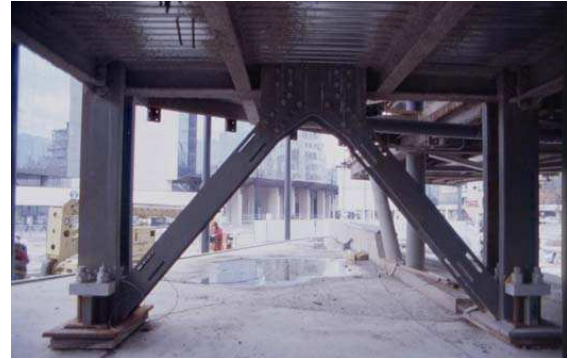
Figure II.11 Exemple des structures à contreventement centré en V
