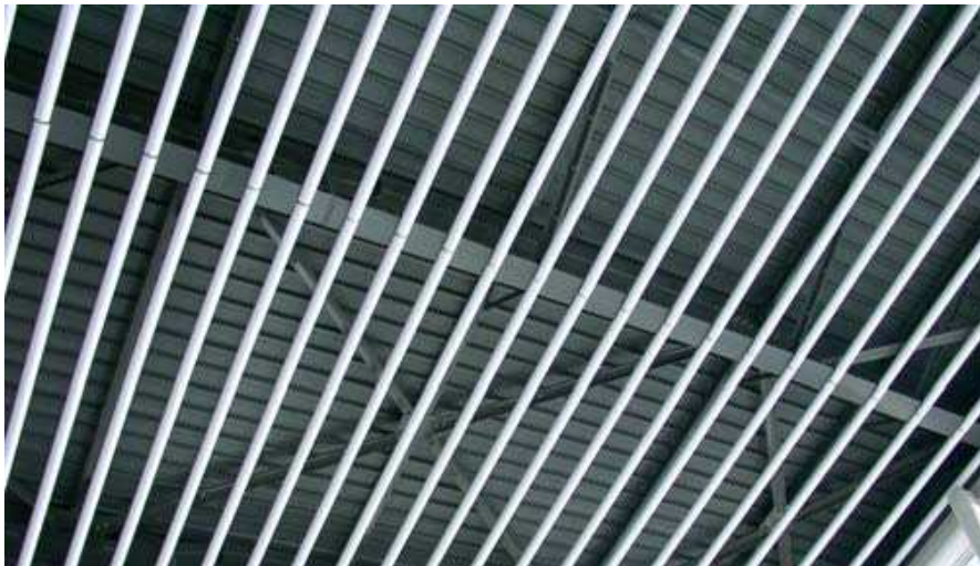
Figure II.3 Contreventement d'une toiture
