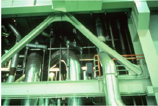
Figure II.11 Exemple des structures à contreventement centré en V
