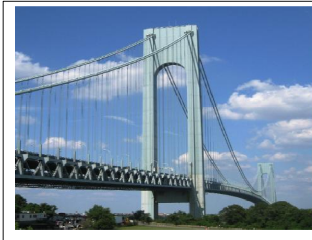
Figure I.3 : Pont Verrazano à New York
