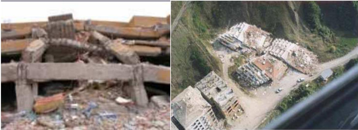
**Figure I.3 :** Mode de ruine fragile (effondrement des structures en béton armé manquant de « ductilité ». (Séisme Boumerdès, Algérie, 2003) à gauche, (Séisme d’Izmit, Turquie, 1999) à droite.
