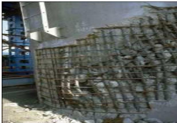
**Figure I.1 :** Comportement ductile (exemple de confinement d'une pile de viaduc. (Document EQIIS –USA). (Séisme de Kobé, Japon, 1995).
