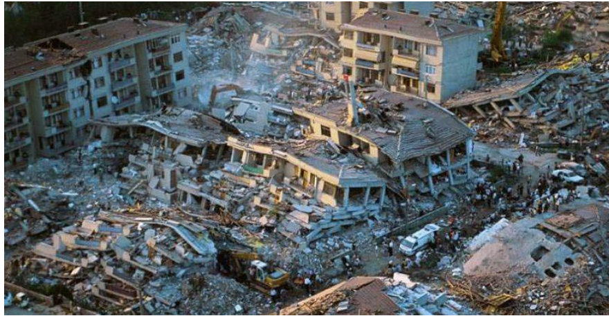
Figure 1.12. Effets d'un séisme sur les structures.
