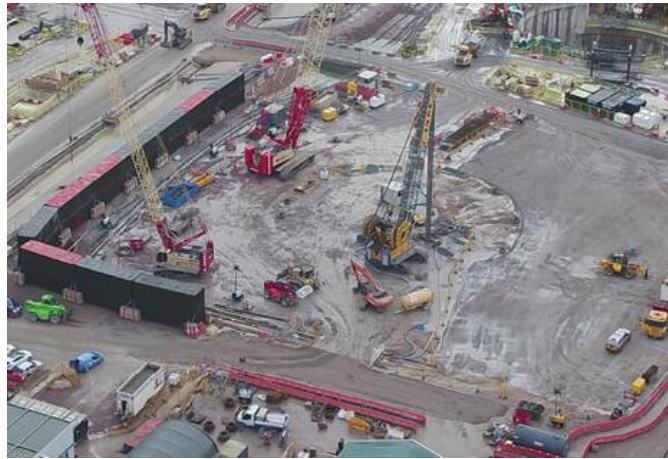
Figure 3.21. Plate-forme de travail.
