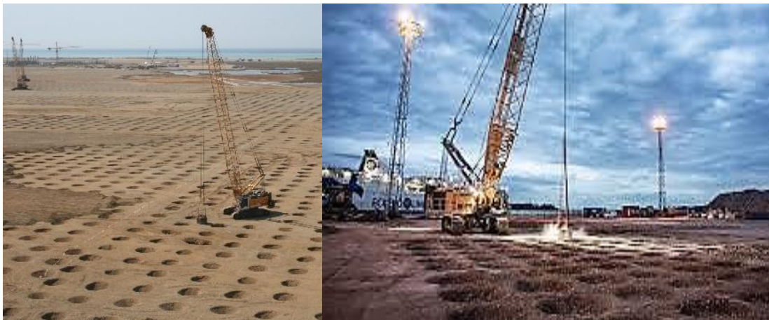
Figure 2.15. Compactage dynamique.
