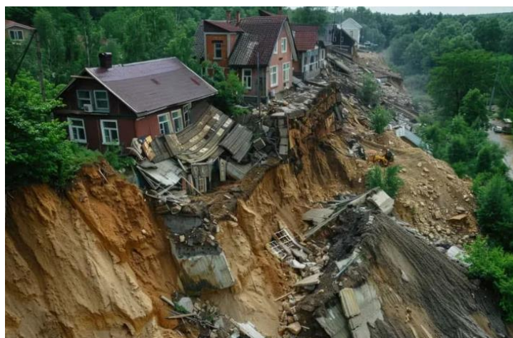
Figure 1.11. Glissement de terrain.
