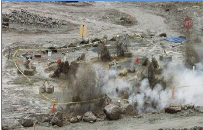
Figure 2.14. Compactage des sols par explosion.
