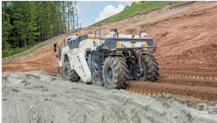
Figure 2.26. Opération de malaxage du ciment avec le sol in situ.
