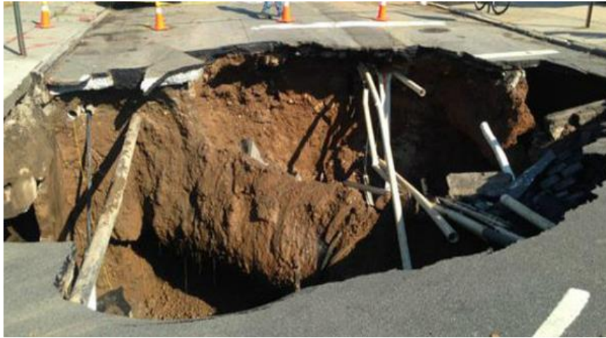
Figure 1.10. Affaissement.
