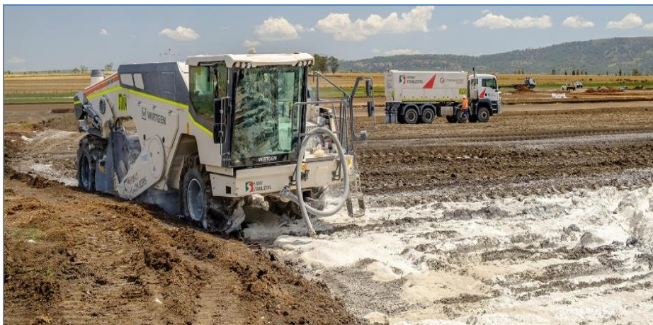
Figure 2.8. Traitement des sols à la chaux.
