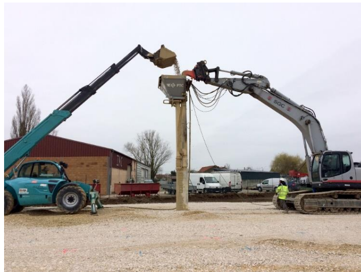
Figure 3.4. Mise en œuvre des colonnes ballastées.
