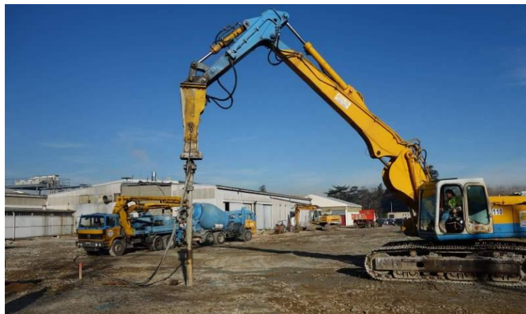
Figure 3.11. Technique d'inclusions rigides préfabriquées.
