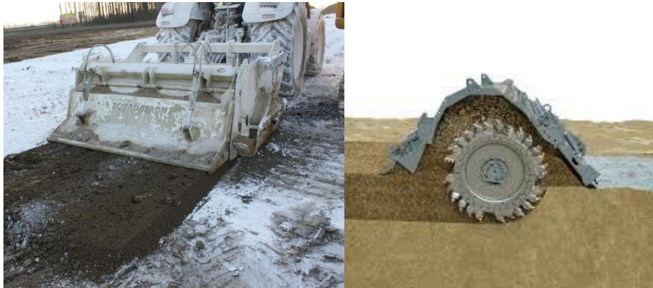
Figure 2.25. Opération de malaxage de la chaux avec le sol in situ.
