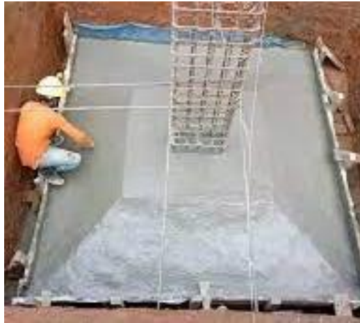
Figure 1.1. Semelle isolée.
