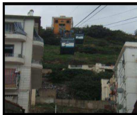
Fig52 : Photo de la ligne téléphérique n°1.
