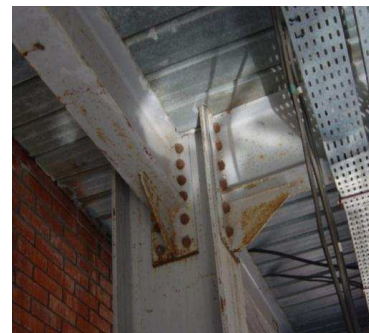
Fig73 : Schéma représentatif de l'assemblage poteau -poutre
