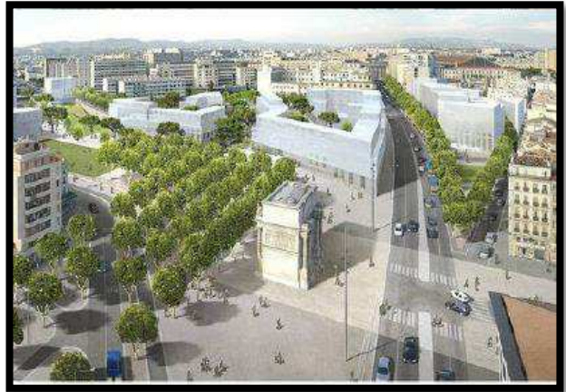
Fig27 : Aménagement du quartier saint Charles.
