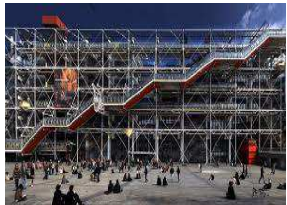
Fig63 : Centre de Pompidou
