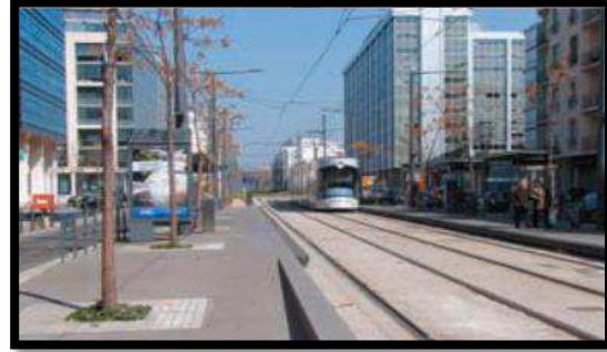
Fig24 : Immeubles de bureaux longeant la ligne de tramway sur le boulevard de dunkerque.
