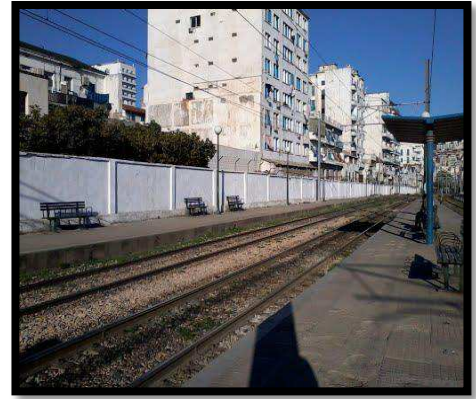
Fig26: Photo de la voie ferrée.
