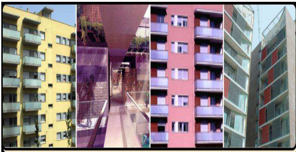
Fig34 : Les logements rénovés.
