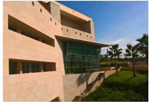
Fig36 : Photo des bureaux.
