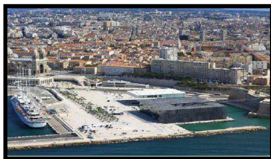
Fig21 : Nouvelle gare maritime.
