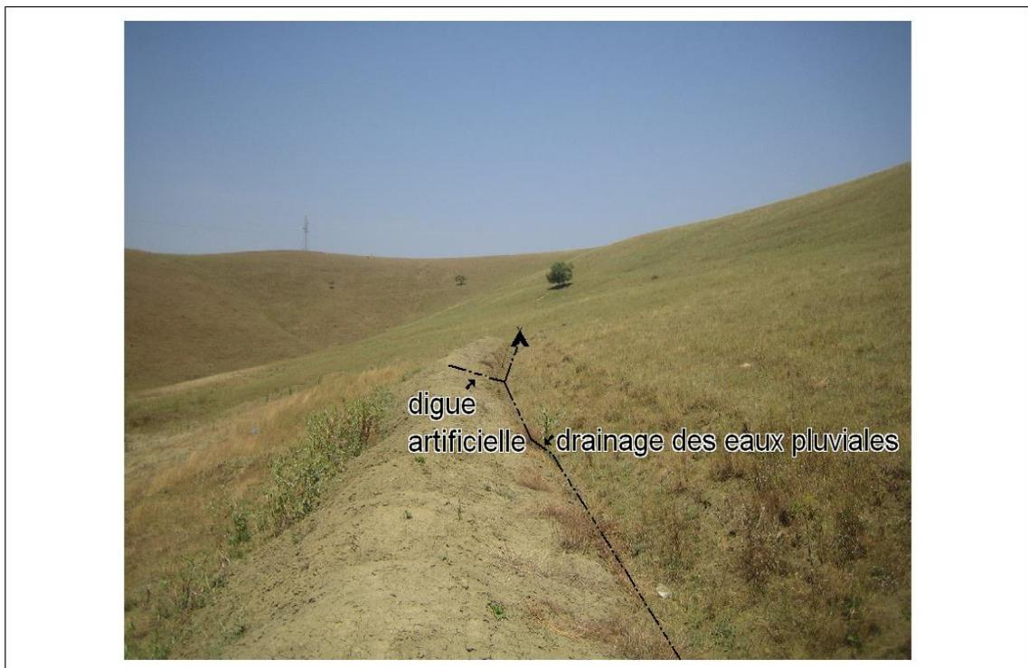
**Figure (9):** représentant un endiguement artificiel.
