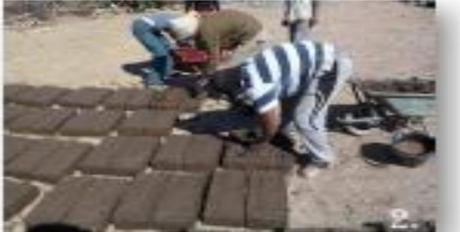
**Figure (11):** Photo de Moulage et séchage des blocs adobe.
