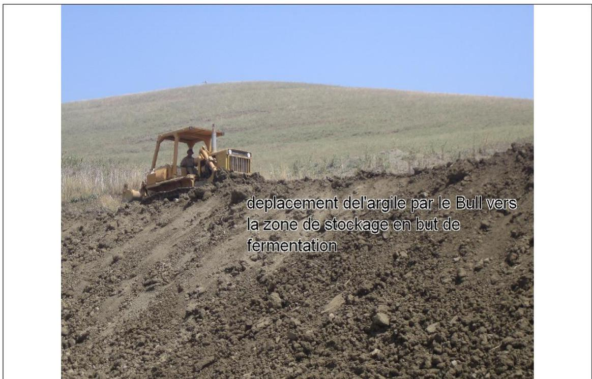
**Figure(6) :** stockage des argiles dans une plateforme.
