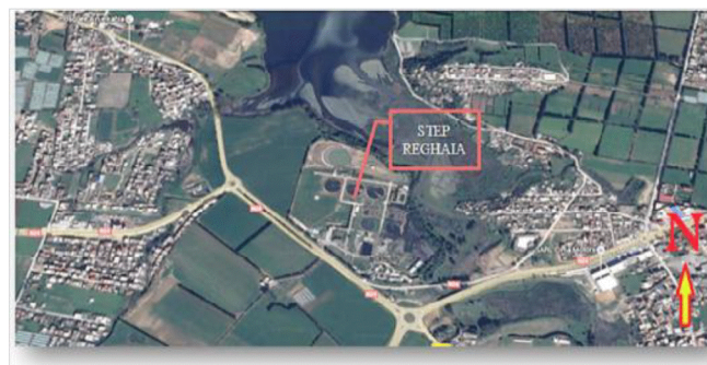
Figure 4 : Localisation de la station d'épurations de Reghaia.
